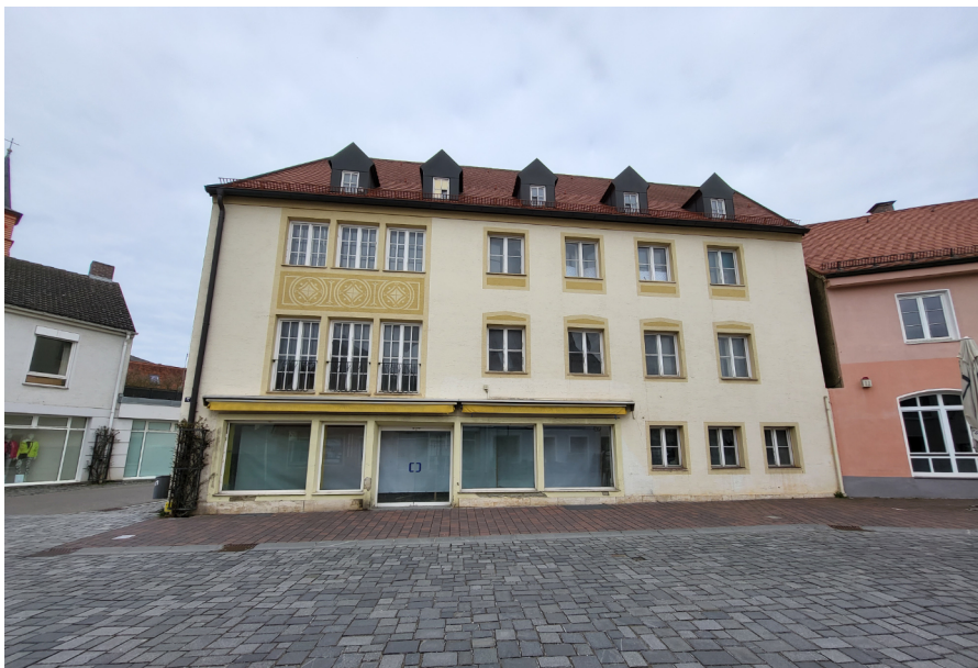
Leerstehendes Gebäude in der Ludwigstraße 17 (GMA, 2023)
