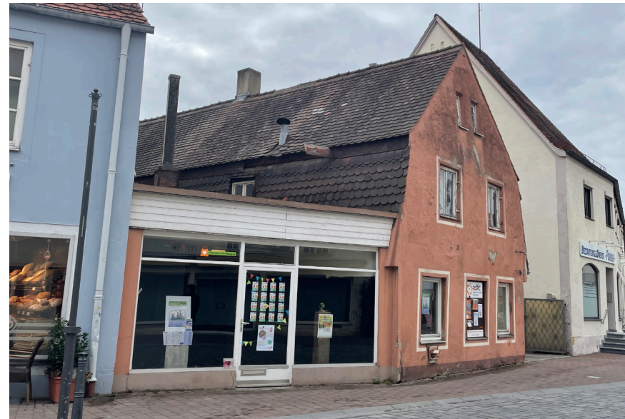
Leerstehendes Gebäude in der Ludwigstraße 21 (GMA, 2023)
