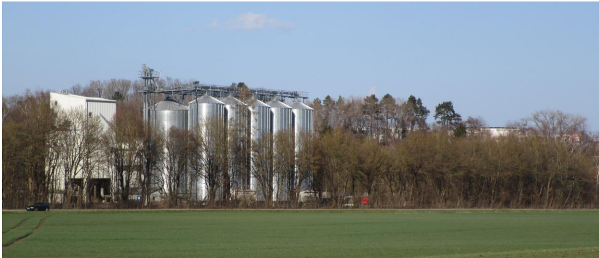
Blick von Südwesten auf die bestehenden Anlagen mit der vorhandenen dichten Eingrünung. Foto: Stadt Land Fritz, März 2021
