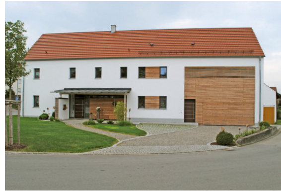
◆ Münsterhausen, Lkr. Günzburg - Ersatzbau für ein-sturzgefährdeten Bauernhof
