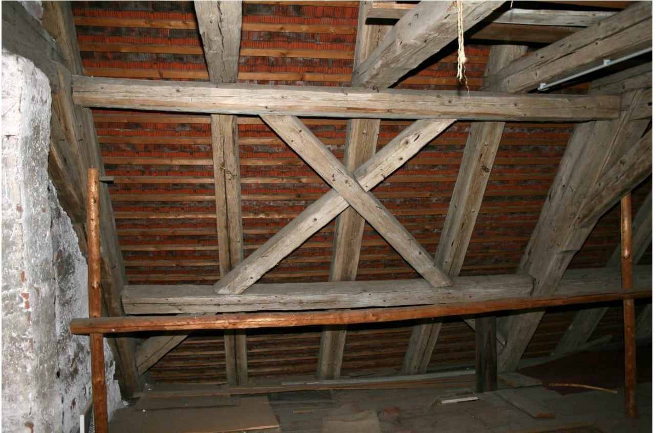
Bild Nr. 136 DG2, Raum Nr. 4.01 nach Osten: Bereich zwischen Binder 5 und 4;
