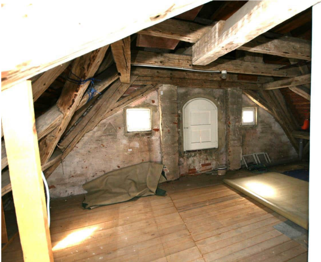
Bild Nr. 124 DG2, Raum Nr. 4.01 nach Südwesten: Südgiebel gemauert (Vollziegel) mit zwei verstärkenden Pfeilervorlagen; in der Mitte vermutlich ehemals als Aufzugsluke genutzte Fensteröffnung mit Segmentbogensturz;
