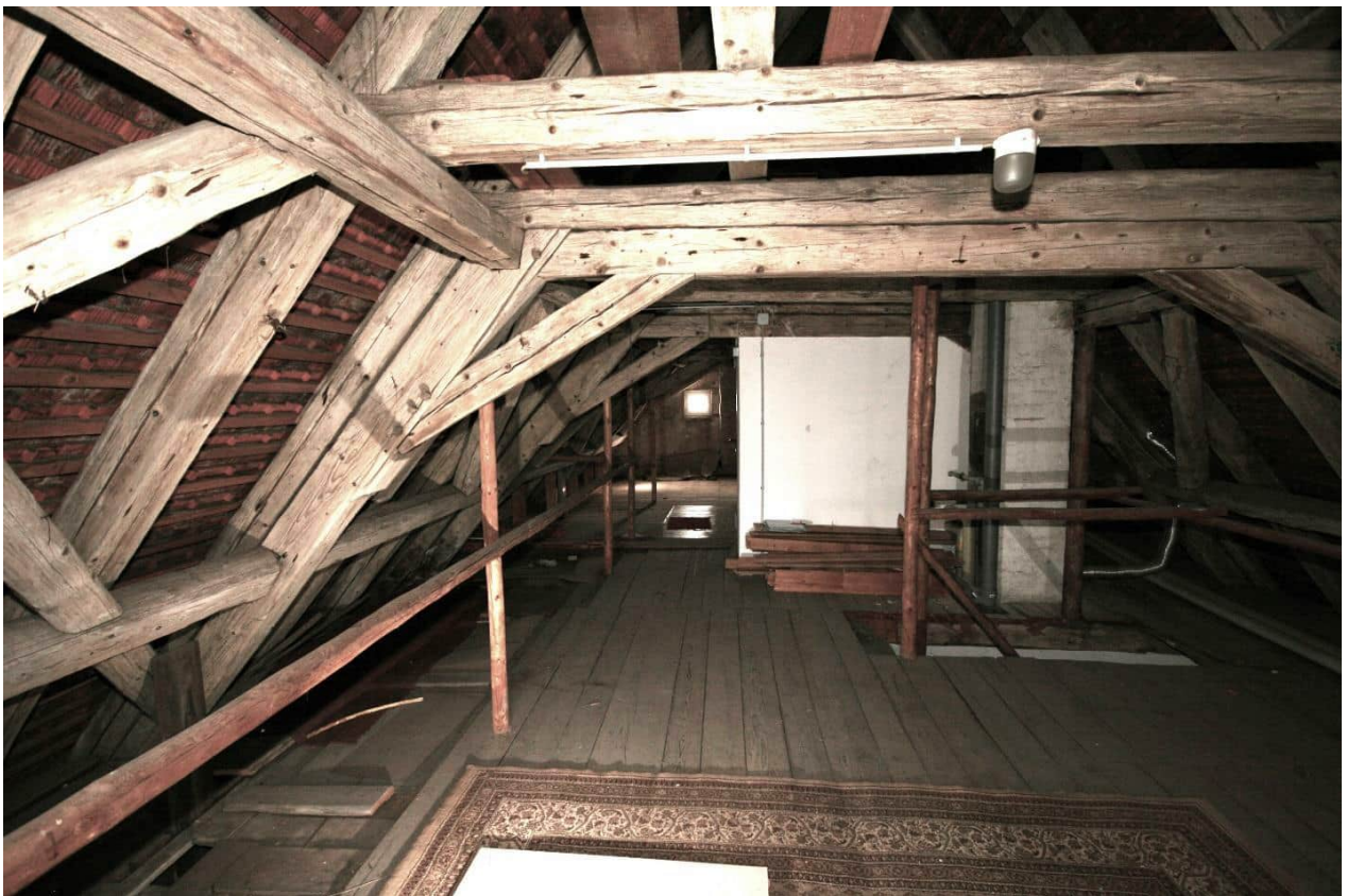
Bild Nr. 123 DG2, Übersicht Raum Nr. 4.01 nach Süden;
