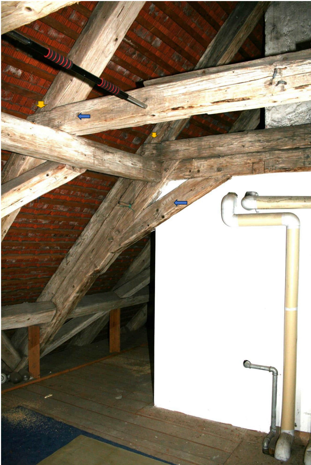
Bild Nr. 126 DG2, Raum Nr. 4.01 nach Nordwesten: Bundachse 2 vor der Heizzentrale; Pfeil: Die Kehlbalken sind an die Sparren von Süden her angeblattet; Blaue Pfeile= Abbundzeichen d. Zimmerers;
