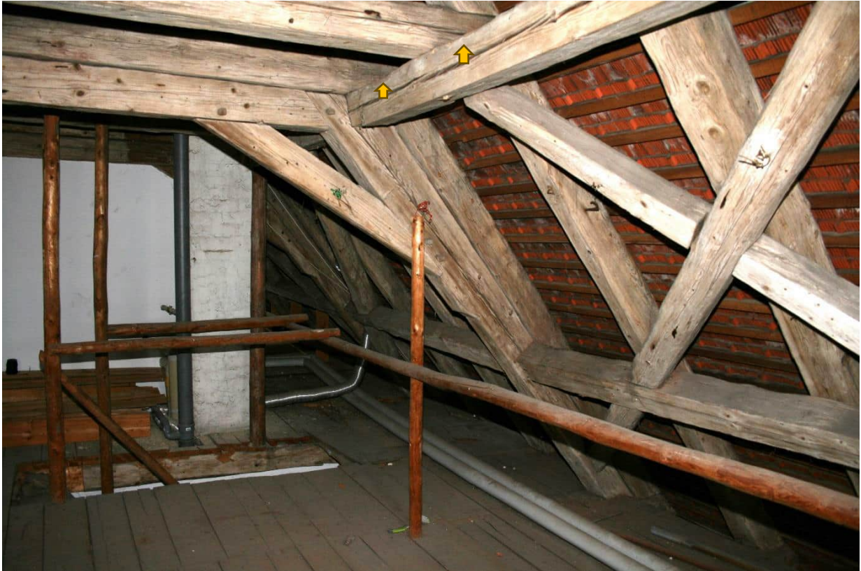
Bild Nr. 129 DG2, Raum Nr. 4.01 nach Südwesten, Bundachse 4: die Überblattung der Kehlbalcken an die Sparren erfolgt hier von Norden (Pfeil);
