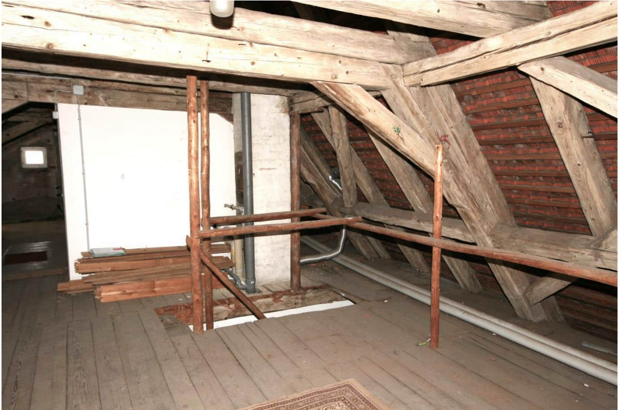
Bild Nr. 122 DG2, Übersicht Raum Nr. 4.01 nach Südwesten mit eingefügter Heizzentrale;
