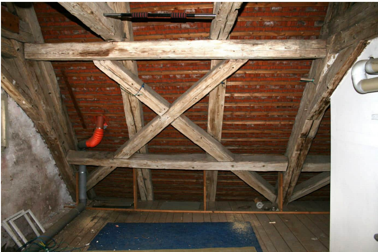
Bild Nr. 125 DG2, Raum Nr. 4.01 nach Westen: Liegender Kehlalkendachstuhl; hier: zwischen Binder 1 und 2: 2 Leergespärre, Brustriegel und Strebenkreuz, rechteckiges Längsrähm;
