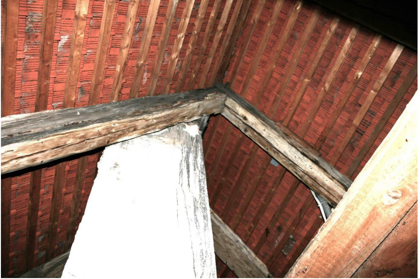
Bild Nr. 143 DG2, Raum Nr. 4.01 nach Norden mit Firstausschnitt: Die Sparrenpaare sind im First miteinander verzapft; Dachhaut= Lattung + Ziegelplatten
