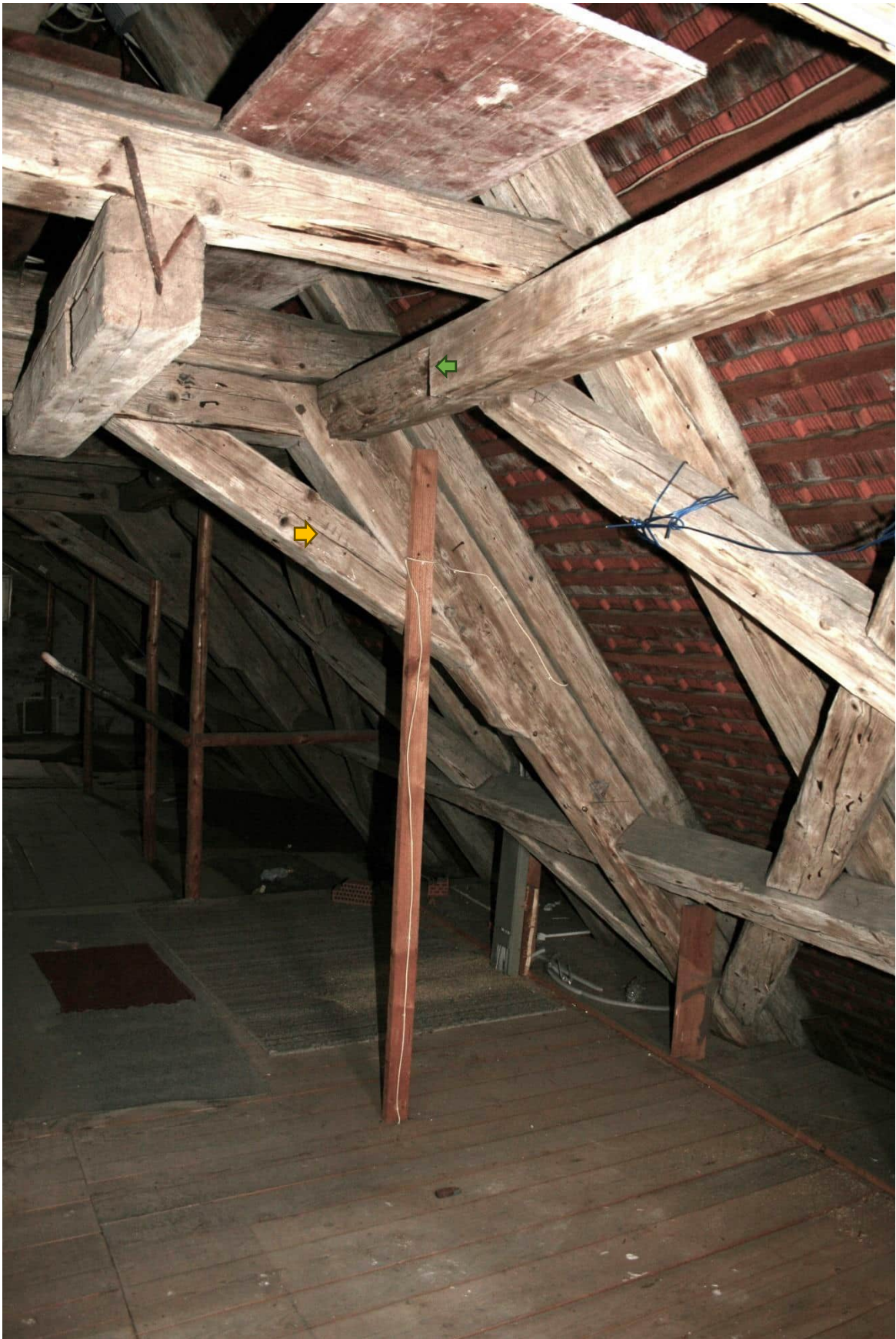
Bild Nr. 140 DG2, Raum Nr. 4.01 nach Nordosten: Bundachse 2; gelber Pfeil: Zimmermannsmäßige Abbundzeichen IIII; von Süden gezählt wie vor (siehe auch Bild Nur 121); Pfeil grün: Das Rähm ist seitlich schräg abgebeilt (für ehem. Kaminführung);
