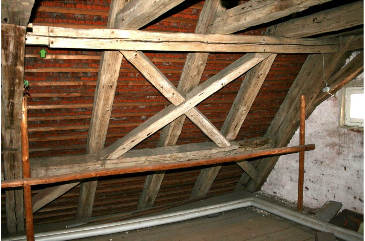
Bild Nr. 132 DG2, Raum Nr. 4.01 nach Nordwesten: zwischen Binder 4 und 5; Pfeil grün: Rähmstoß vor dem Binder wie vor;
