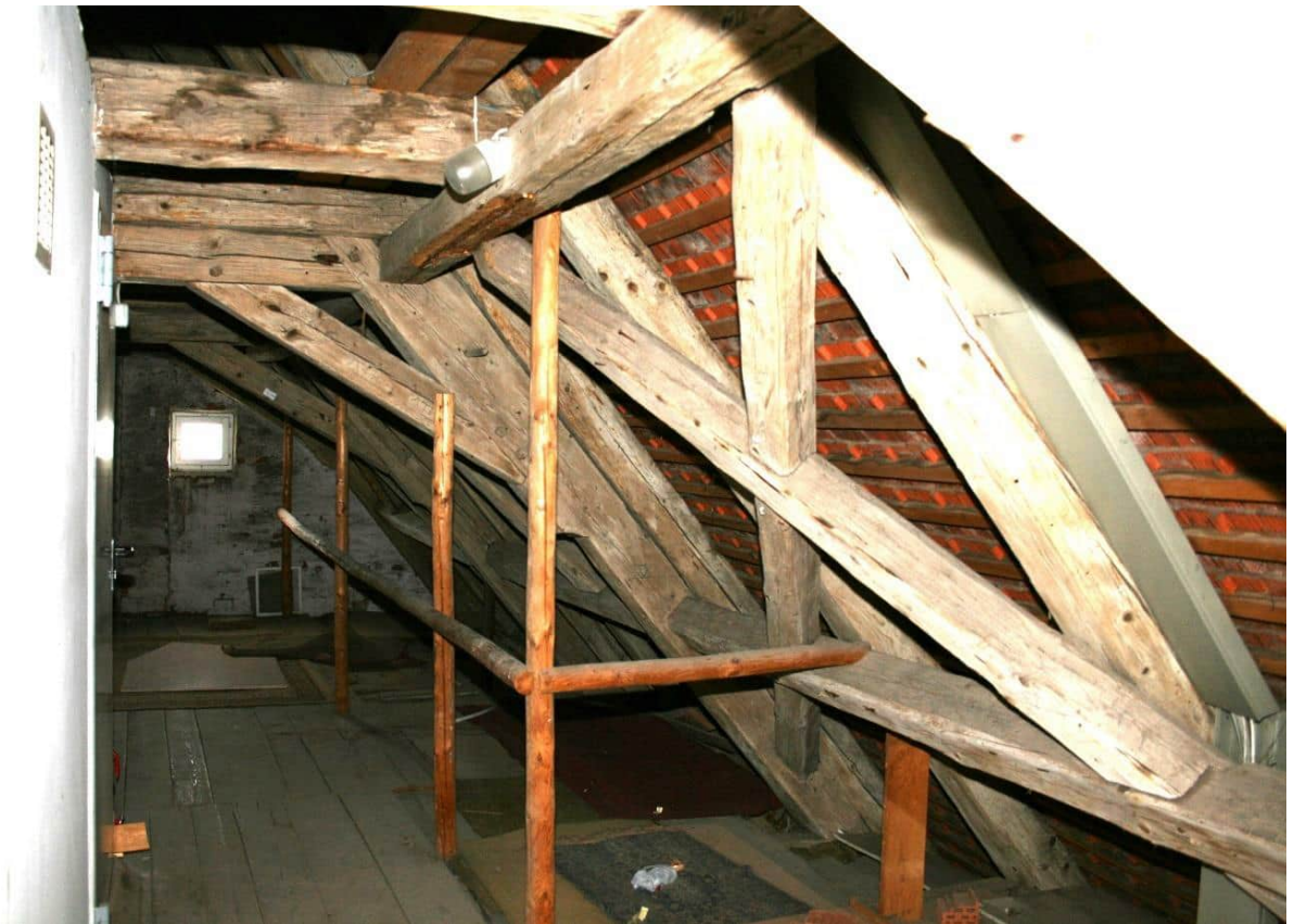
Bild Nr. 138 DG2, Raum Nr. 4.01 nach Nordosten: Bundachse 3;
