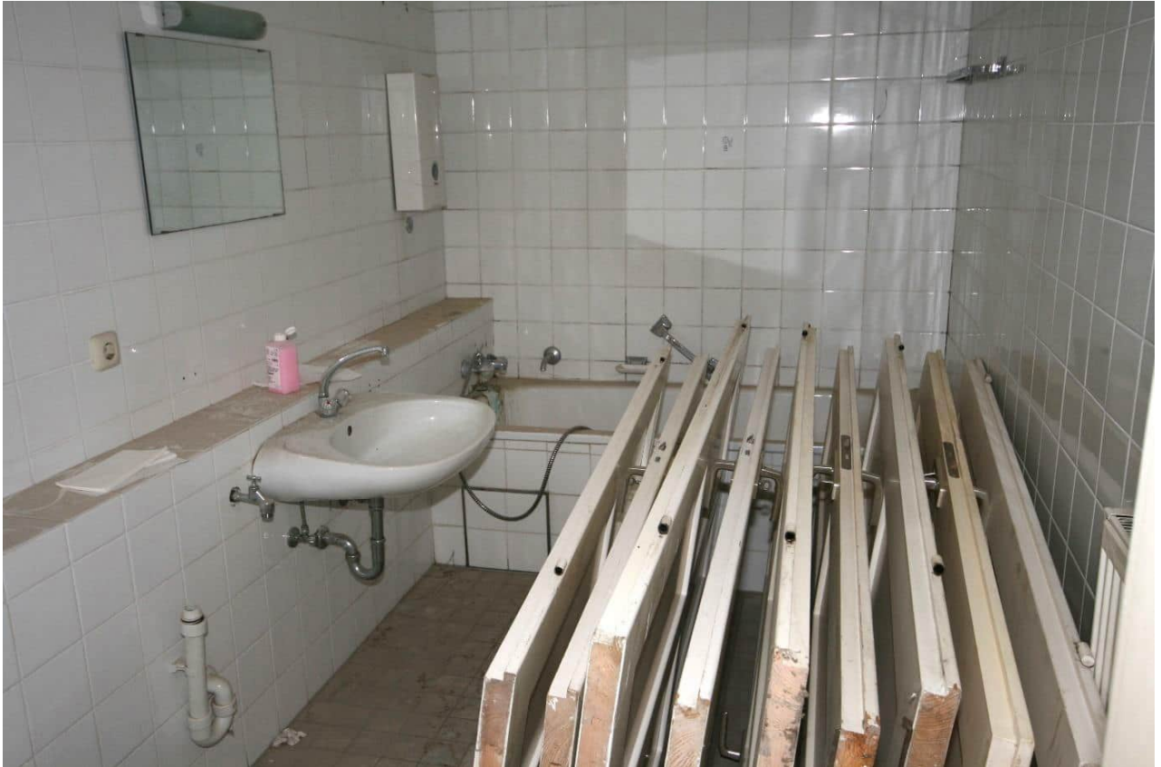
Foto Nr. 25 OG, Übersicht Raum Nr. 1.08 nach Norden; Boden: Fliesenbelag auf Estrich, Decke: wie vor;
