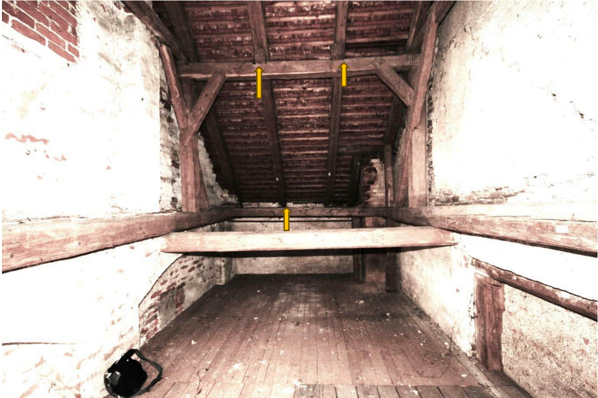
Foto Nr. 33 R.1.11 nach Osten:Pfeile= abgetrennte Kehlbalcken und Wechsel der Stichbalcken(ehem. Zerrbalcken);
