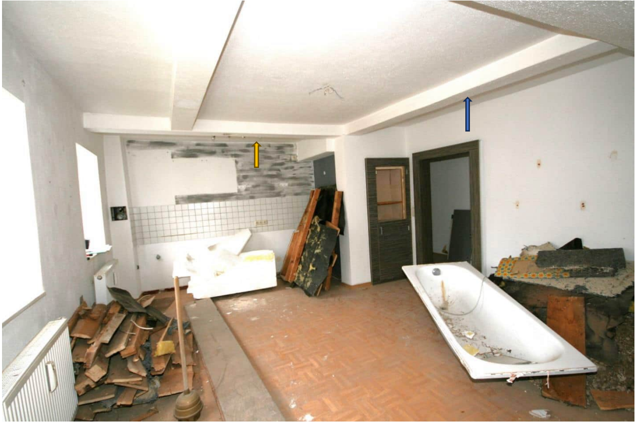
Foto Nr. 90 DG1, Raum Nr. 3.01 nach Westen; blauer Pfeil=Bundbalken Bundachse2; gelber Pfeil= Mittelrähm des Kehlalkendachwerks
