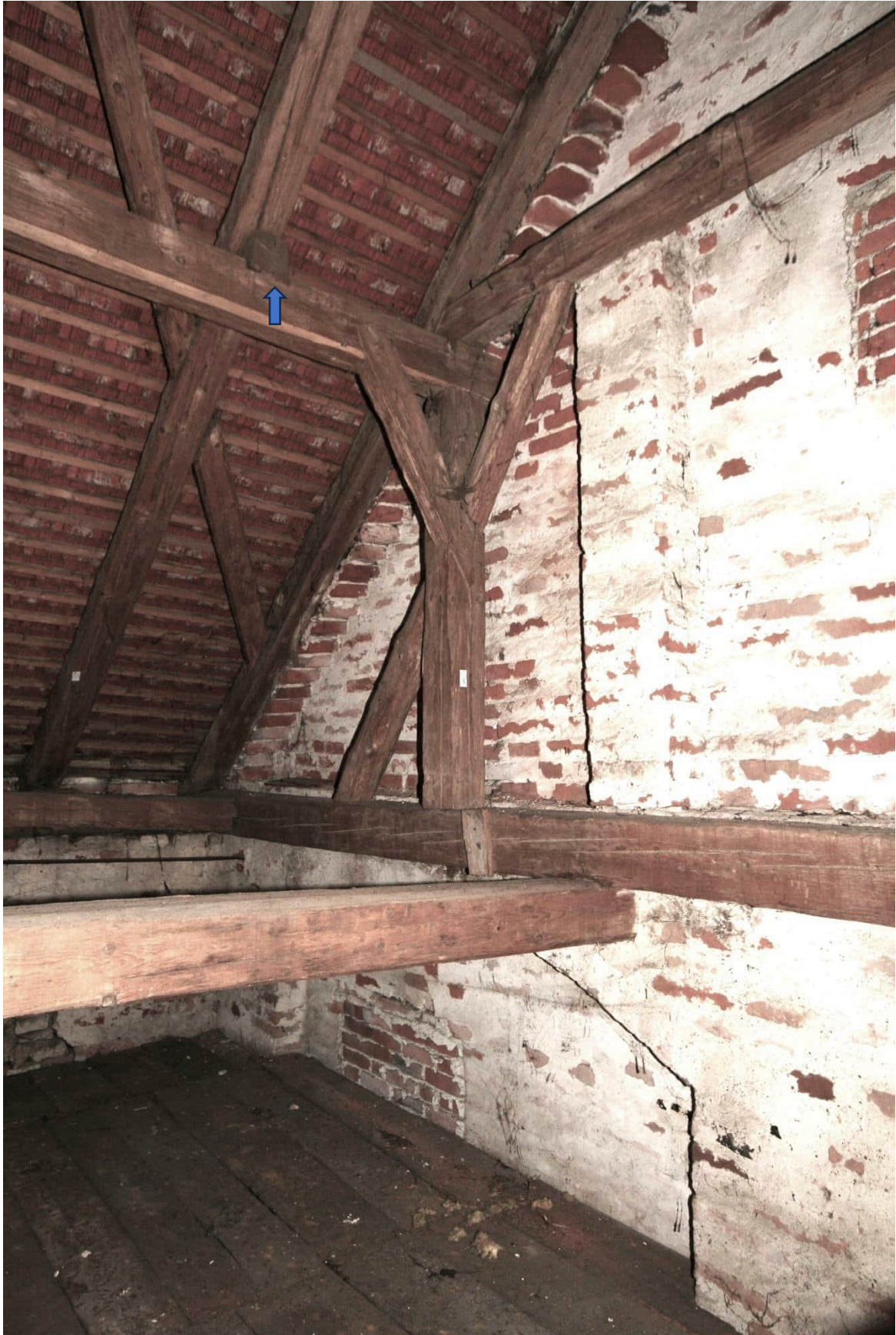
Foto Nr. 34 R.1.11 nach Nordwesten: Gemauerte Außenwand aus Vollziegel mit Pfeilervorlagen; Nordwestliche Bundstütze auf Zerrbalken; die Längsaussteifung (in Firstrichtung)= Kopfband auf Rähm und Stütze geblattet, die Queraussteifung= Steigband über Zerrbalken, Bundstütze und Kehlbalken geblattet; Pfeil= abgetrennter Kehlbalken;
