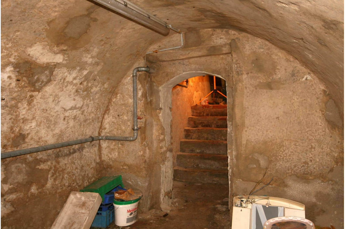
Foto Nr. 58 KG, Raum Nr. -1.02 nach Osten: Tonnengewölbe wie vor mit Türöffnung und Treppenansatz;
