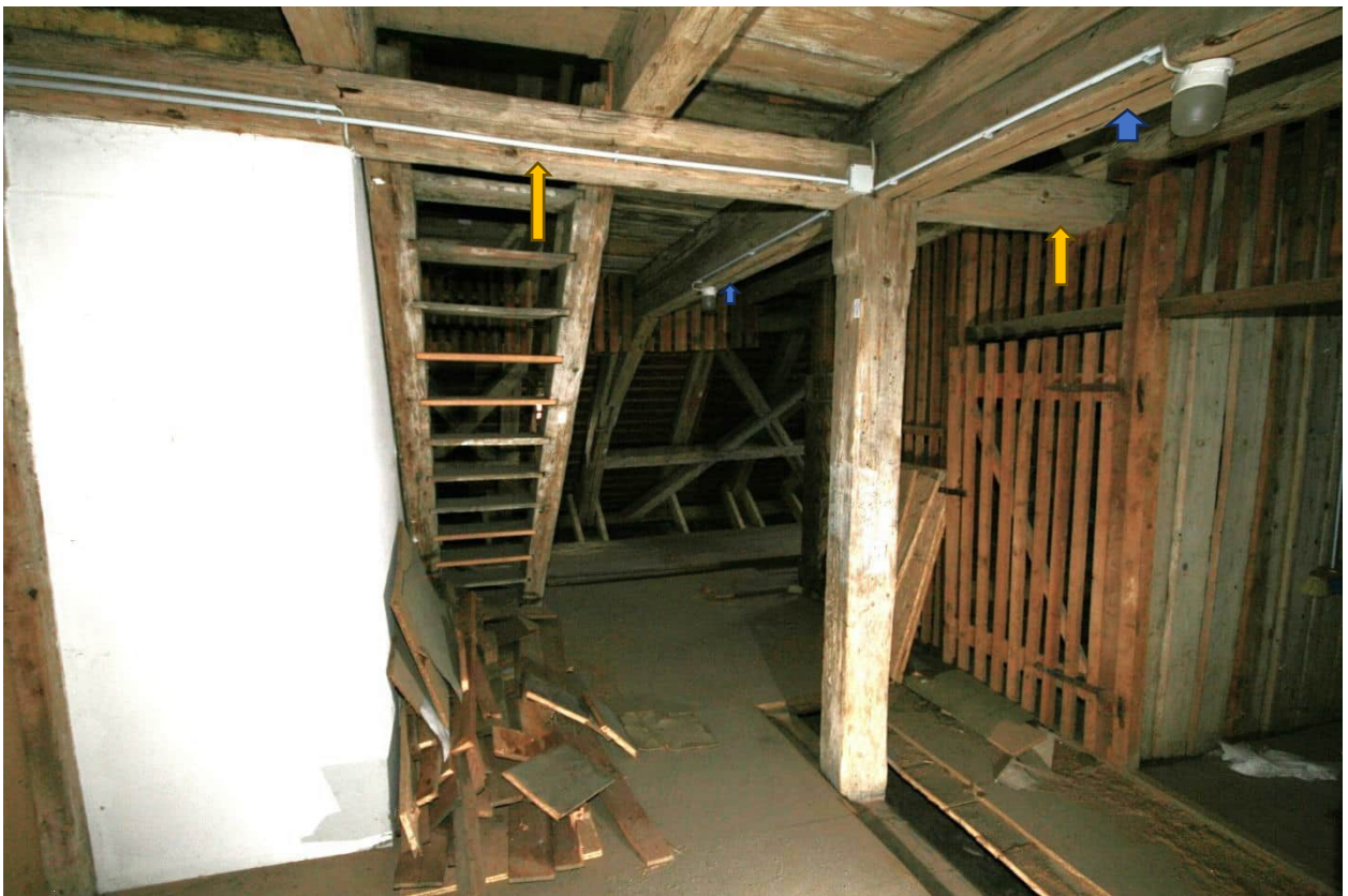
Foto Nr. 100 DG1, Raum Nr. 3.04 nach Westen: Mittelstützenreihe (Pfeil) in Nord-Südrichtung mit Mittelstütze der Bundachse 4 darüber Längsrähm, einläufige Treppe mit eingeschobenen Trittstufen zum DG2; Blaue Pfeile= Bundbalken, darüber Kehlbalken;
