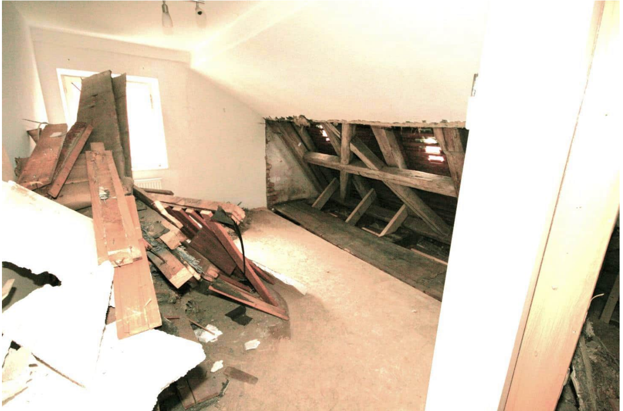
Foto Nr. 94 DG1, Übersicht Raum Nr. 3.02 nach Südwesten;
