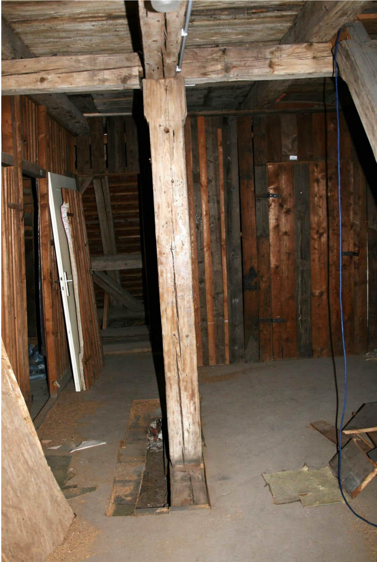
Foto Nr. 109 DG1, Raum Nr. 3.04 nach Osten: Mittelstütze Bundachse 4, Stützenkopf verbreitert mit zweiseitiger Schmuckfase;
