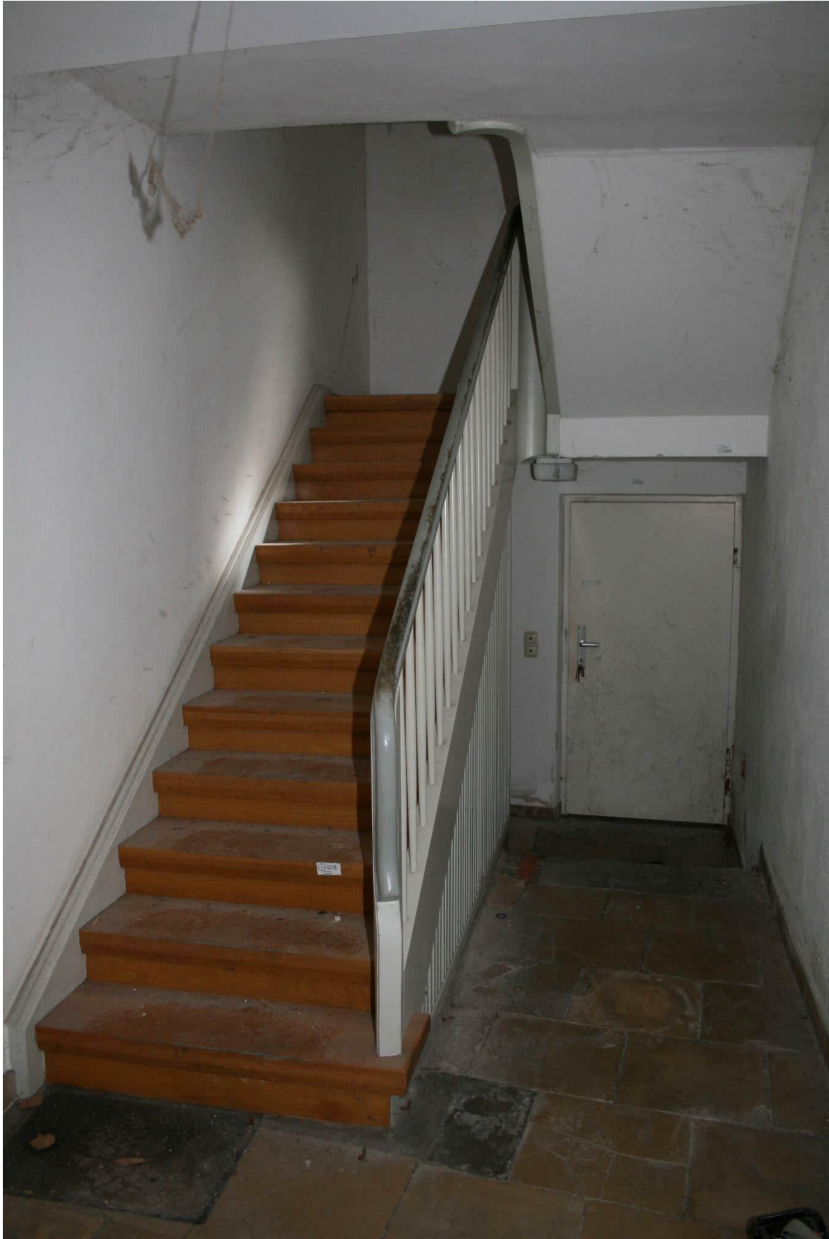
Foto Nr. 18 EG, Raum Nr. 0.05 Querflur nach Osten: Wangentreppe zweiläufig (Tritt- und Setzstufen) als Stockwerkstreppe mit Zwischenpodest; Geländerstäbe gedrechselt; rückwärtige Tür zum Innenhof;
