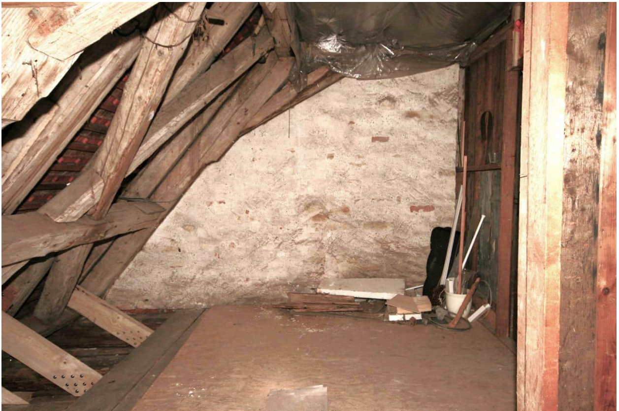
Foto Nr. 114 DG1, Raum Nr. 3.04 nach Süden, östlicher Dachbereich Bundachse 3 und nördliche, gemauerte Treppenhauswand;
