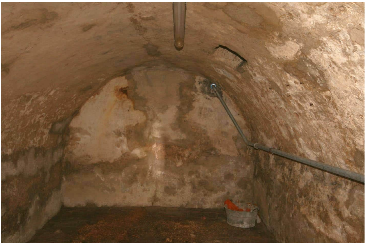
Foto Nr. 57 KG, Raum Nr. -1.02 nach Westen: Tonnengewölbe gemauert wie vor, mit mittig ansetzendem Kämpfer; zugesetzte Lichtnische;
