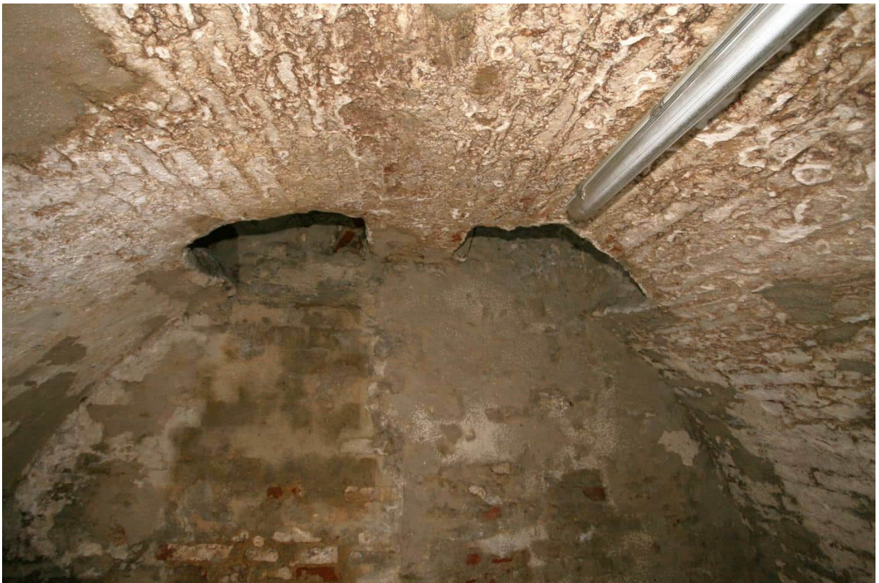
Foto Nr. 55 KG, Raum Nr. -1.01 nach Süden: Tonnengewölbe wie vor; Öffnungen zu Lichtschächten führend;
