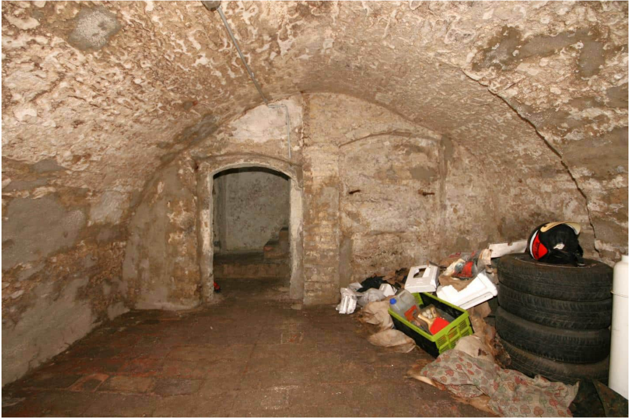
Foto Nr. 56 KG, Raum Nr. -1.01 nach Norden: Tonnengewölbe wie vor; gemauerte Türöffnung mit Wandnische;
