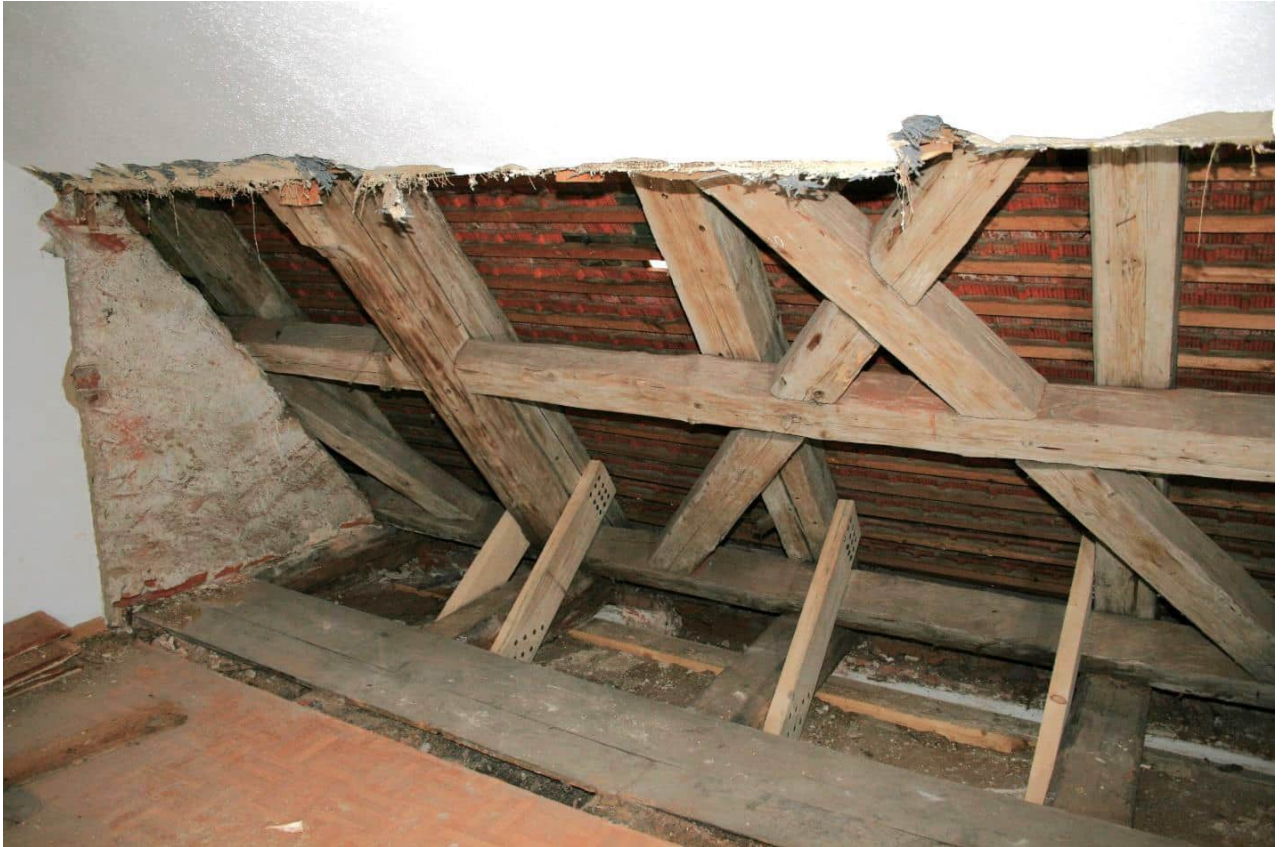
Foto Nr. 92 DG1, Raum Nr. 3.01 nach Nordosten: Ausschnitt Liegender Dachstuhl wie vor;
