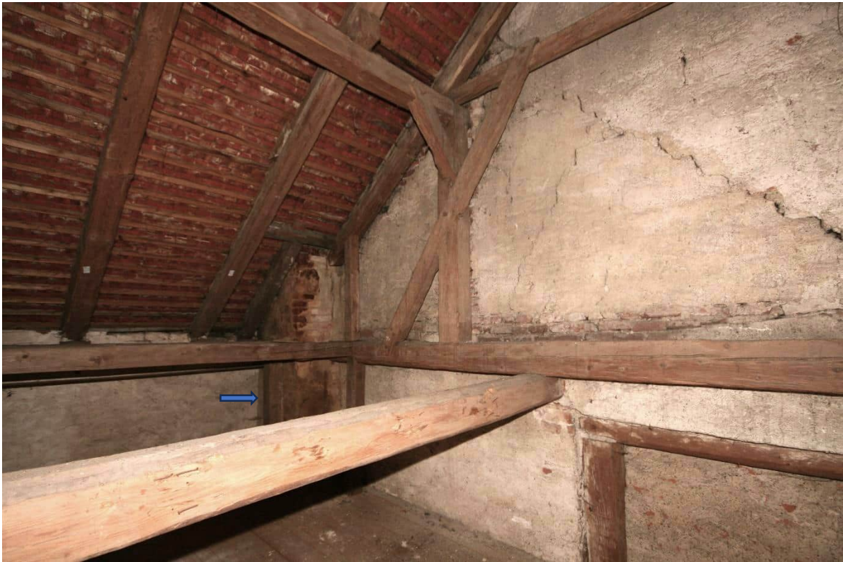
Foto Nr. 42 R.1.11 nach Südosten: Pfeil= Kaminführung;
