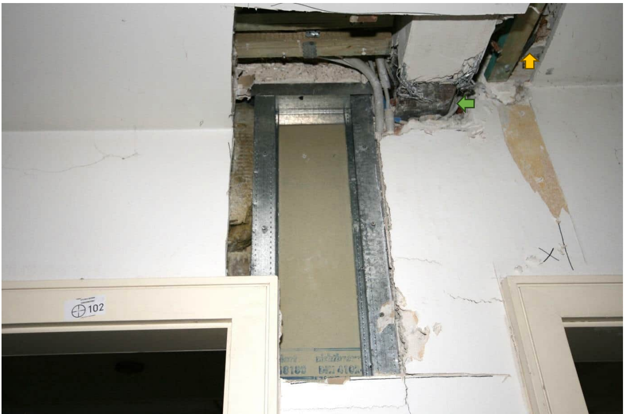
Foto Nr. 22 OG, Raum Nr. 1.10 nach Norden; Wandausschnitt: Gipskartonständerwand mit Dämmung auf Metallrahmen, Decke Gipskarton auf Lattung, darüber Putzdecke (gelber Pfeil); grüner Pfeil: HEA-Profilträger (T-Träger) unter Verputz (HWL-Platten);
