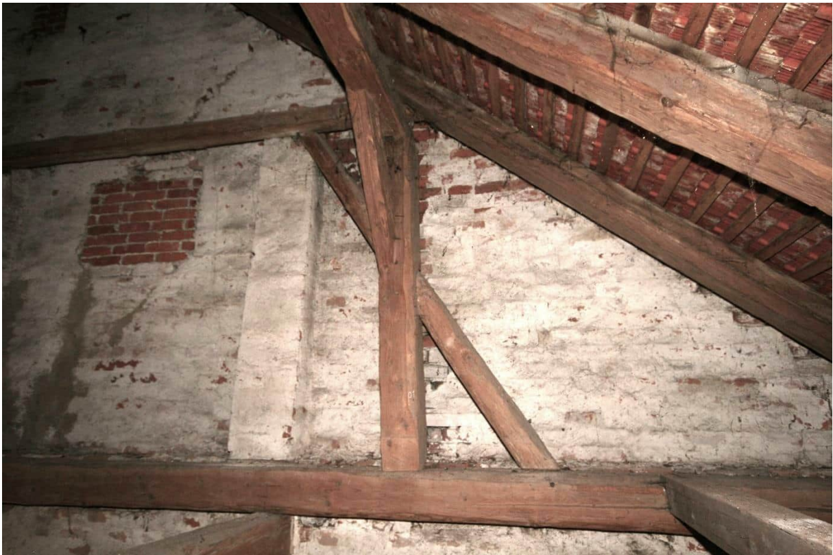
Foto Nr. 48 R.1.11 nach Norden: nördliche Bundachse mit nordöstlichem Bundständer;
