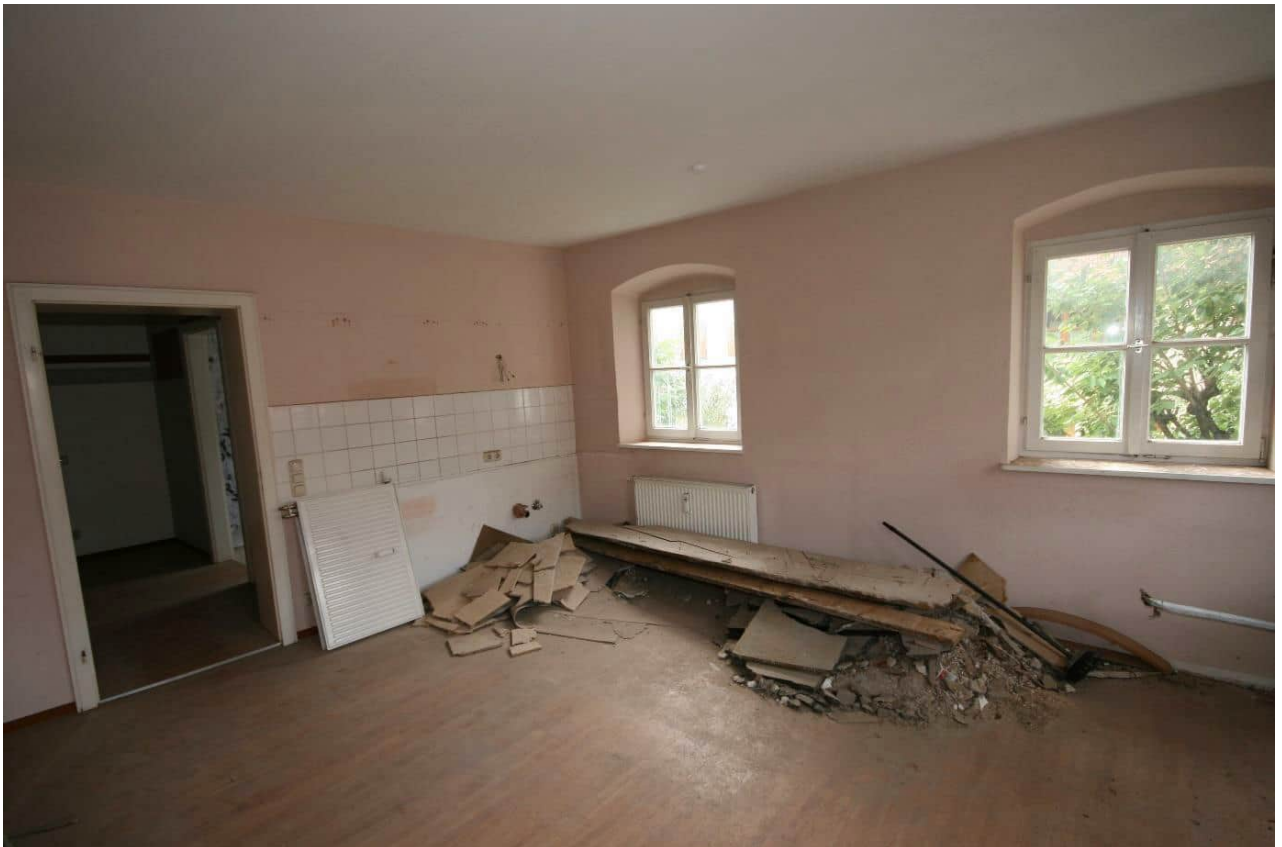
Foto Nr. 17 OG, Übersicht Raum Nr. 1.01 nach Südosten;
