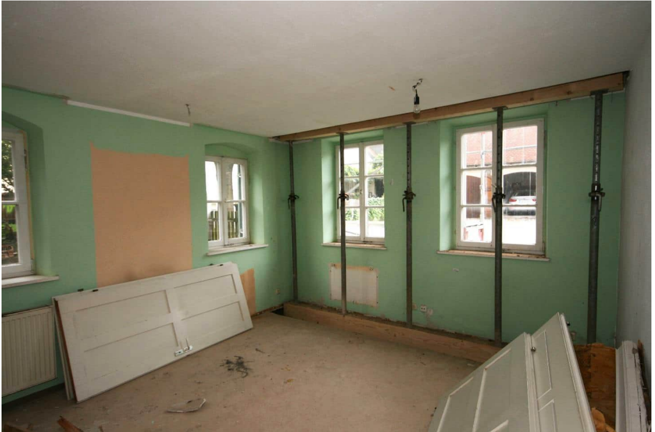
Foto Nr. 64 EG, Übersicht Raum Nr. 0.01 nach Südwesten, statische Präventivmaßnahmen wie vor; unterschiedliche Fenstergrößen und Sturzausbildungen in der Süd- und Westwand;
