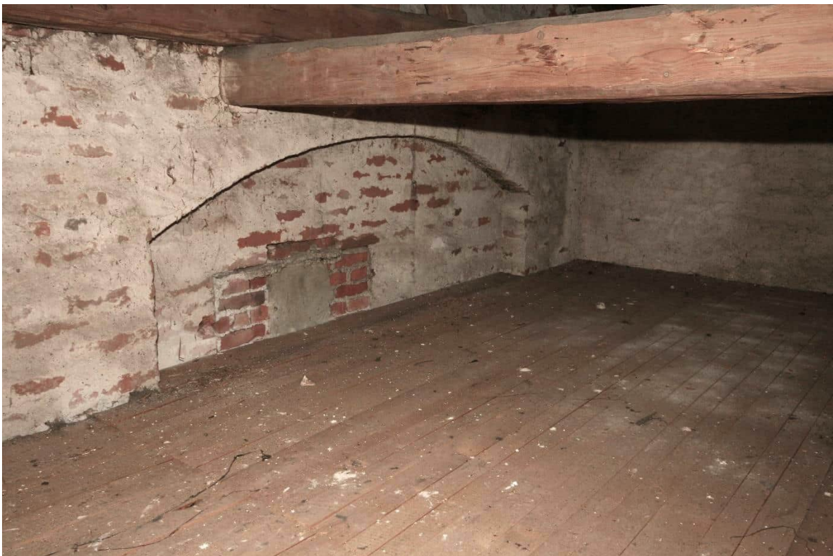
Foto Nr. 44 R.1.11 nach Nordosten: Wandscheibe in Sparmauerweise (Ziegel, Stichbogensturz) unterhalb des Dachwerks;
