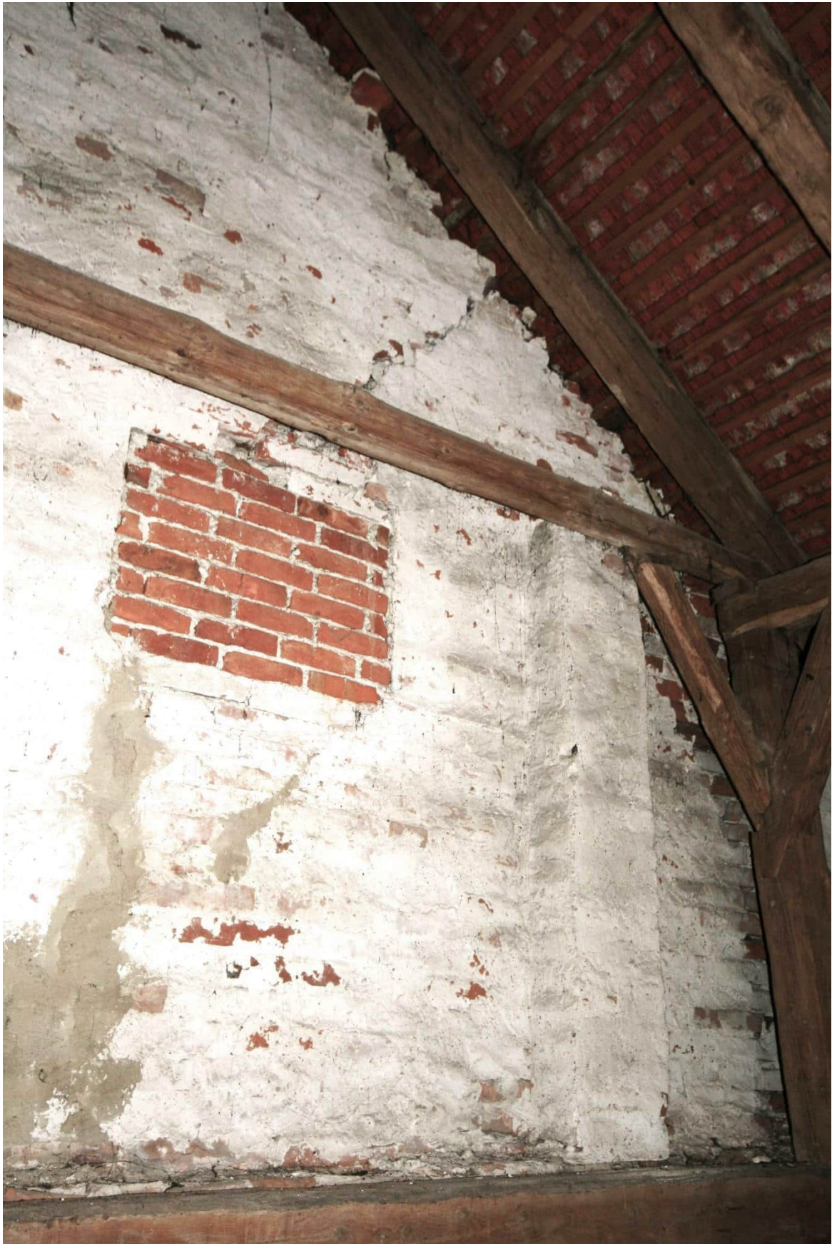
Foto Nr. 51 R.1.11 nach Nordosten: zugesetztes Fenster und nordöstliche Bundstütze;
