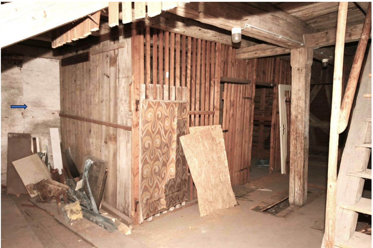
Foto Nr. 102 DG1, Übersicht Raum Nr. 3.04 nach Nordosten; Pfeil= nördliche Giebelwand des Hauptbaus; Gelber Pfeil= Mittelstütze Bundachse 4 zwischen Längsrähm und Zerrbalken eingezapft;
