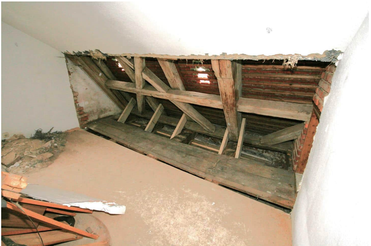
Foto Nr. 95 DG1, Raum Nr. 3.02 nach Südwesten: Ausschnitt Liegender Kehlbalkendachstuhl wie vor zwischen Bundachsen 1 und 2;
