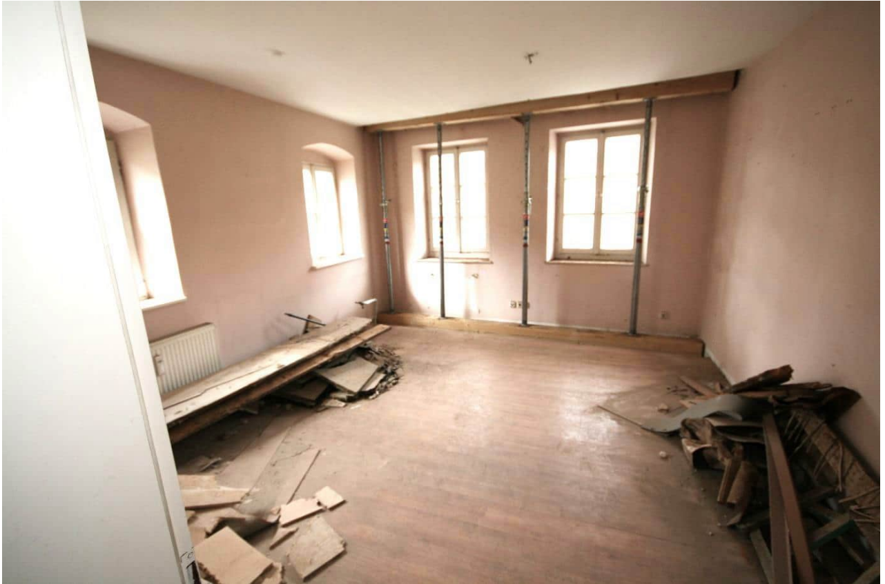
Foto Nr. 16 OG, Übersicht Raum Nr. 1.01 nach Südwesten: Boden und Decke wie vor; unterschiedliche Fensterstürze in der Süd- und Westwand;
