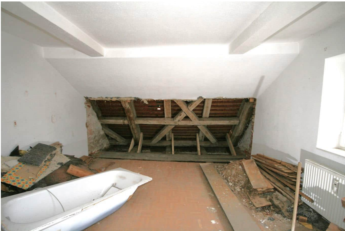
Foto Nr. 89 DG1, Raum Nr. 3.01 nach Osten: Freigelegter Wandbereich des liegenden Kehl balkendachstuhl; hier: Bereich zwischen Bundachse 1 und 2, liegende Stuhlsäulen (konisch nach oben verbreitert), dazwischen Riegel mit Kreuzstreben und 2 Zwischengesparren, Fünfeckschwelle (siehe Querschnitt);
