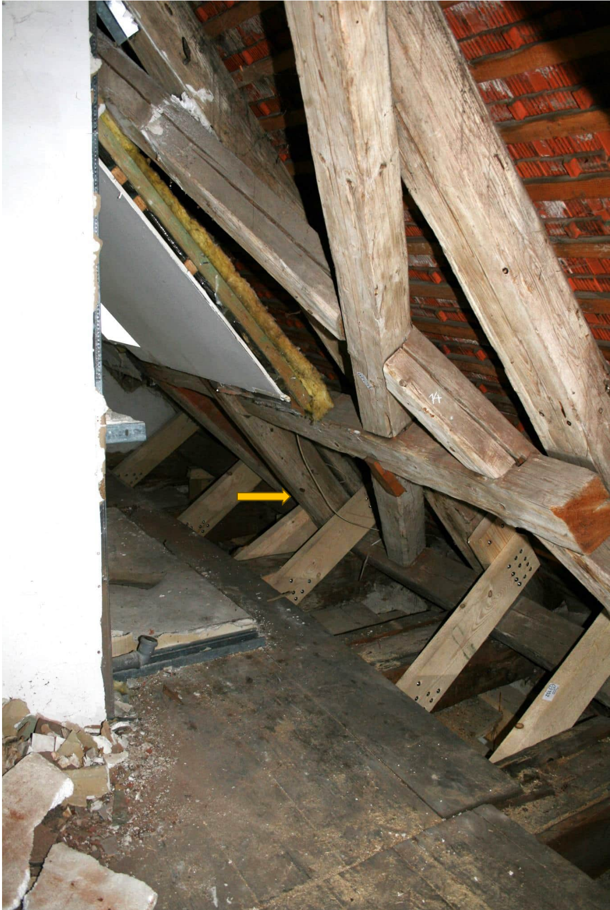
Foto Nr. 103 DG1, Raum Nr. 3.04 nach Süden in Raum Nr. 1.03: Ausschnitt westliche Traufpunktseite, Pfeil= Stuhlsäule Bundachse 3, Sparren 7*;
