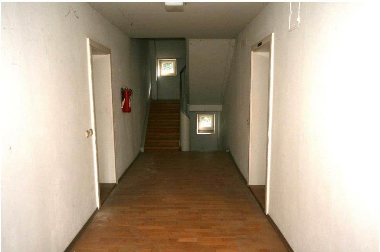
Foto Nr. 11 OG, Raum Nr. 1.05, Querflur nach Osten mit Stockwerkstreppe, sonst wie vor;
