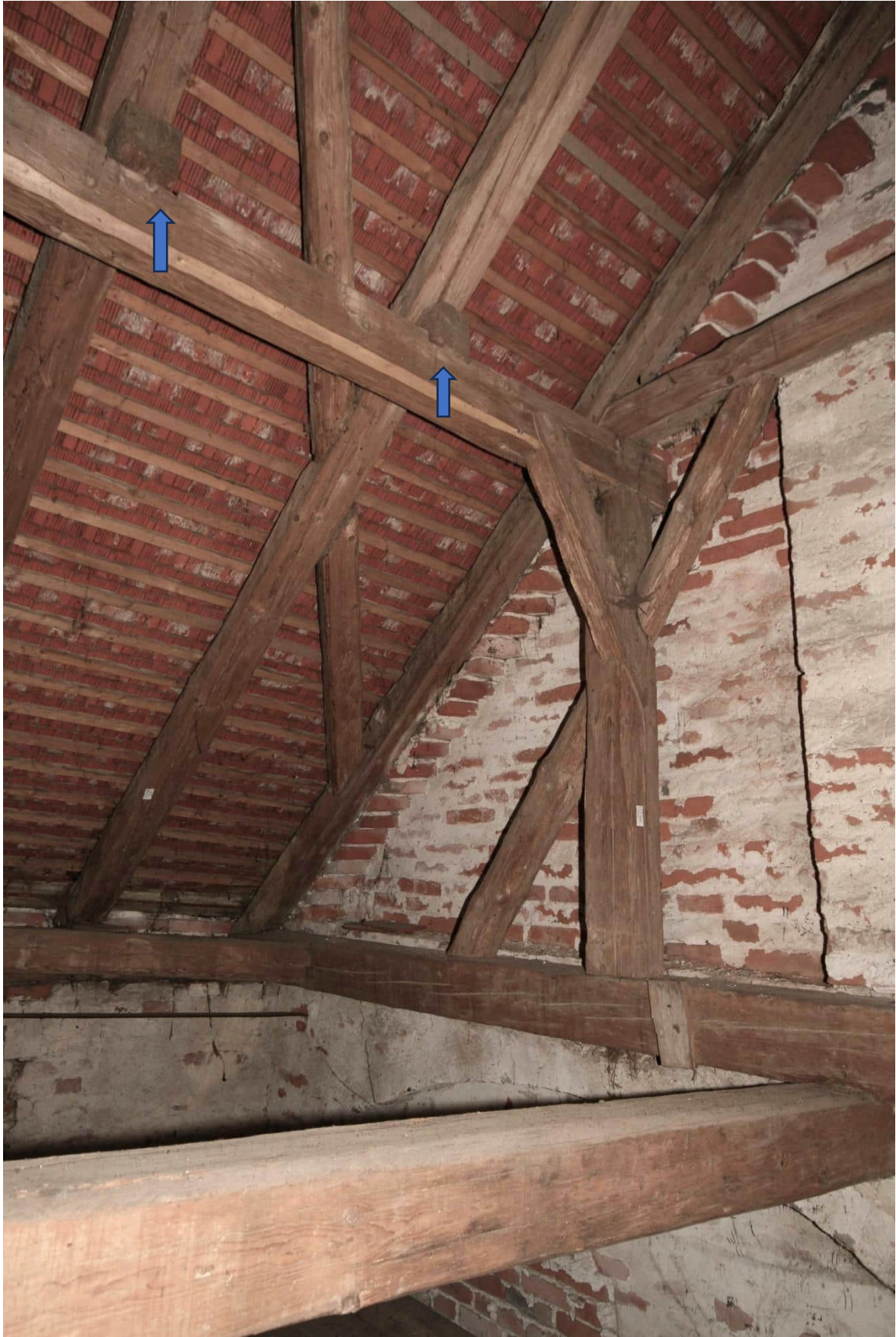
Foto Nr. 36 R.1.11 nach Nordwesten: Stehender Kehlbalckenstuhl, hier die nordwestliche Bundstütze, sonst wie vor; Pfeile= abgetrennte Kehlbalcken
