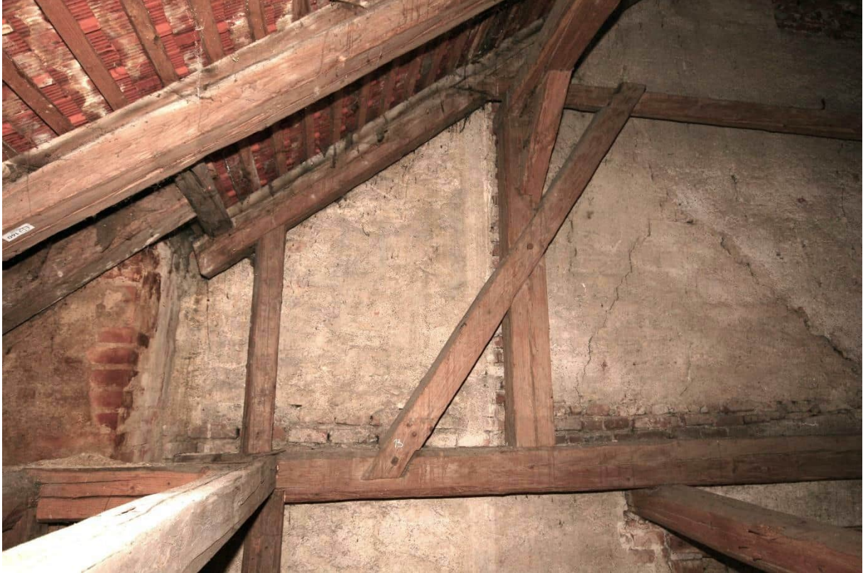
Foto Nr. 47 R.1.11 nach Süden: links spätere Kaminführung, rechts südöstliche Bundstütze;
