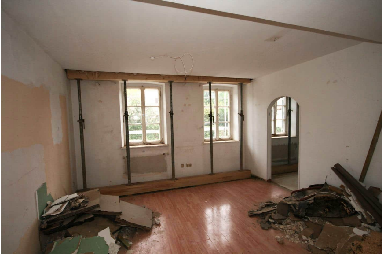
Foto Nr. 67 EG, Übersicht Raum Nr. 0.11 nach Nordwesten: Abstützungsmaßnahmen für Deckenbalken;
