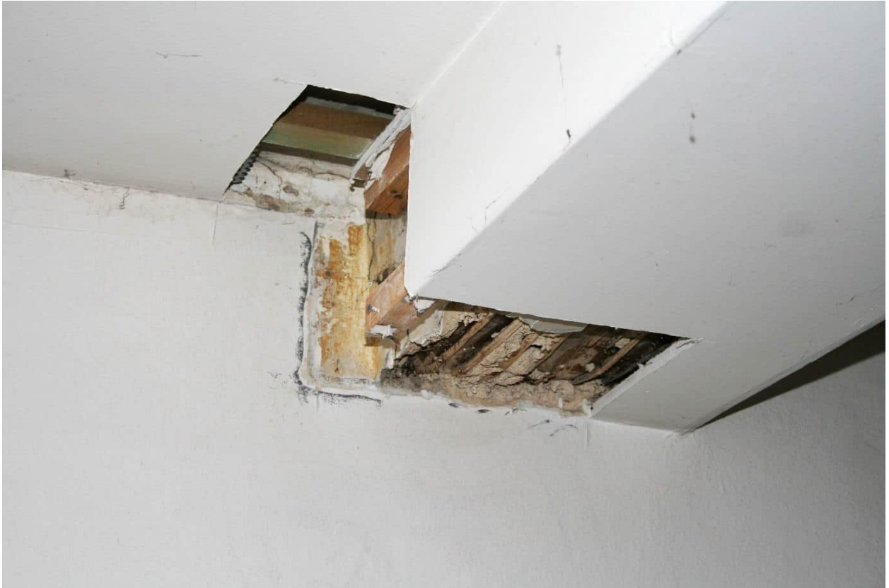
Foto Nr. 28 OG, Raum Nr. 1.07 nach Norden; Deckenausschnitt: Balkenunterzug unter Verputz und Fassungen; Putzträger: Haselruten; darunter Gipskarton auf Lattung wie vor, Decke ebenso;
