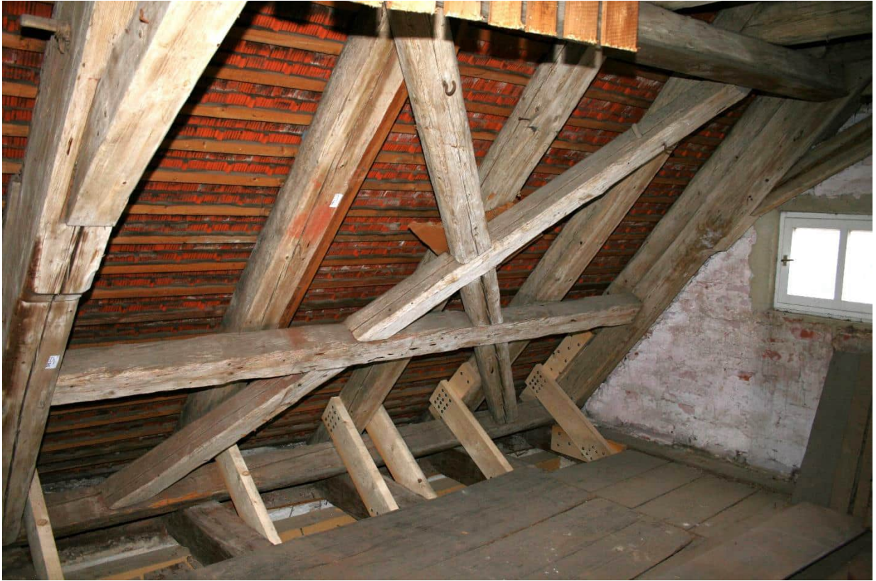
Foto Nr. 106 DG1, Raum Nr. 3.04 nach Nordwesten: Kehlbalkendachstuhl im Bereich der Bundachsen 5 und 4 mit 3 Zwischengesparren und nördliche Außenwand;
