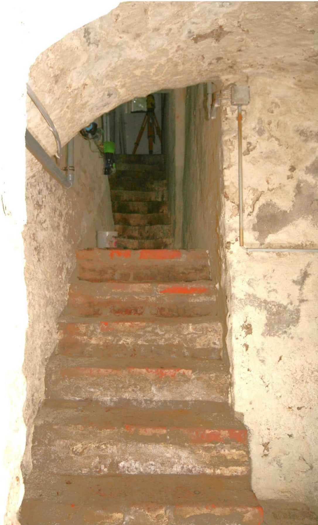
Foto Nr. 53 KG, Raum Nr. -1.00 nach Osten: Treppenabgang gemauert, mit Zwischenpodest;
