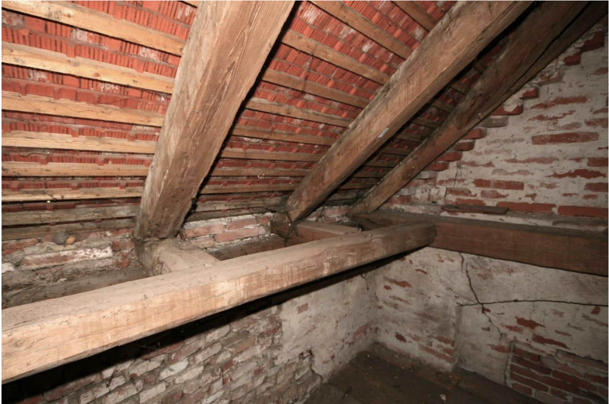
Foto Nr. 37 R.1.11 nach Nordwesten: Stichbalkenlage der Zwischensparren mit Wechselbalken zwischen den Zerrbalken der Bundachsen;
