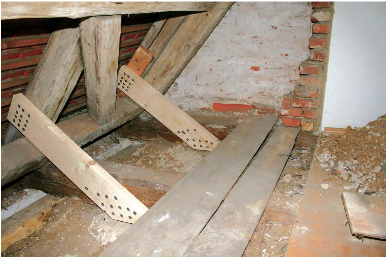
Foto Nr. 93 DG1, Raum Nr. 3.01 nach Süden: Ausschnitt Fünfeckschwelle mit seitlichen Beilaschungen, Zerrbalken/ Sparren, sonst wie vor;
