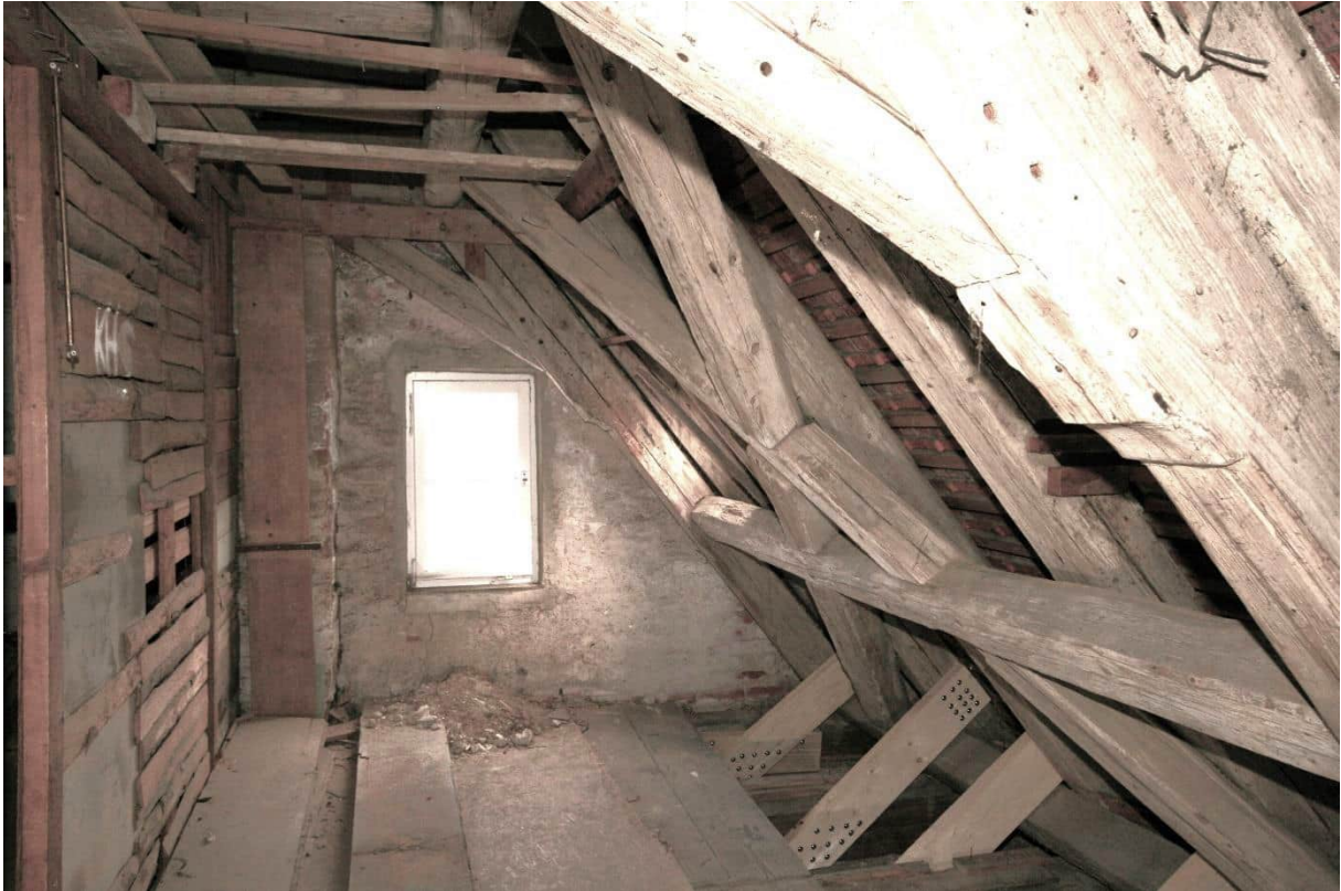
Foto Nr. 112 DG1, Raum Nr. 3.04 nach Norden: Bereich zwischen Bundachse 4 und 5 sowie östlicher Teilbereich des Nordgiebels: gemauert, mit Pfeilervorsatz wie vor;
