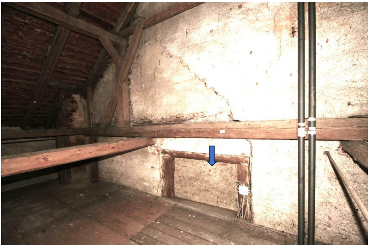
Foto Nr. 40 R.1.11 nach Südosten: Südwand mit zugesetzter Türöffnung;
