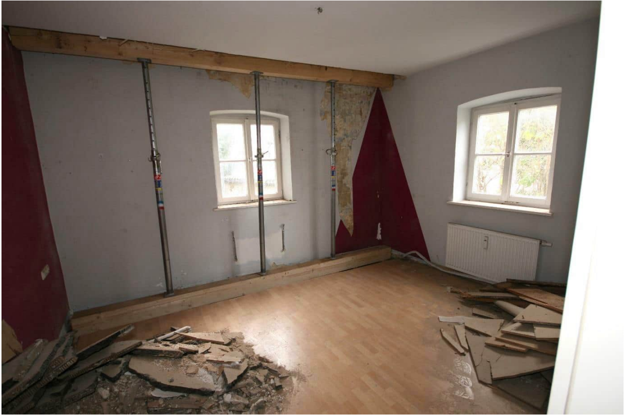
Foto Nr. 12 OG, Übersicht Raum Nr. 1.04 nach Südosten; Boden: PVC-Belag auf Estrich, Decke: Gipskarton, darüber Putzdecke auf Haselruten und Bretterlage als Putzträger;
