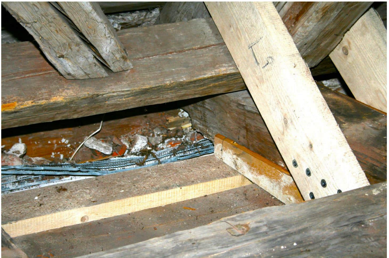
Foto Nr. 98 DG1, Raum Nr. 3.02 nach Nordwesten, Ausschnitt Fußpunkt Bundachse 2:Fünfeckschwelle mit seitlichen Sicherungsbeilaschungen über Stuhlsäulenfuß, Sparrenfuß und Zerrbalken;
