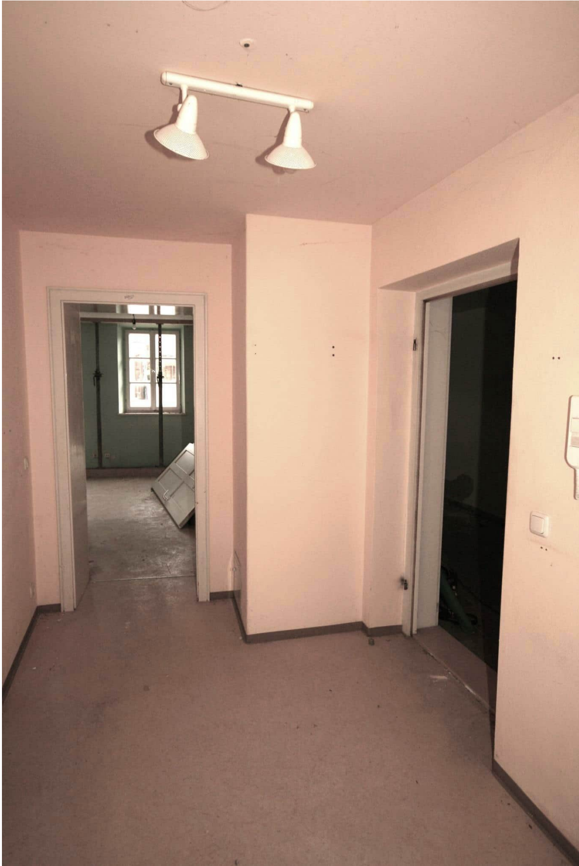
Foto Nr. 63 EG, Übersicht Raum Nr. 0.02 nach Westen: Wohnungsdiele mit Kaminführung;
