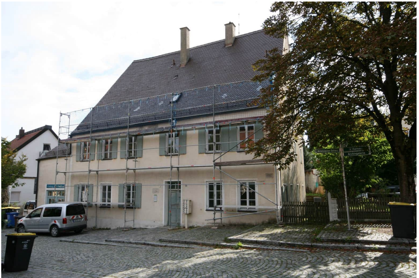
Foto Nr. 06, Westansicht;
