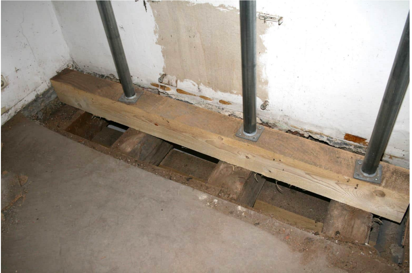
Foto Nr. 30 OG, Raum Nr. 1.06 nach Nordosten: Statische Sicherung wie vor;
