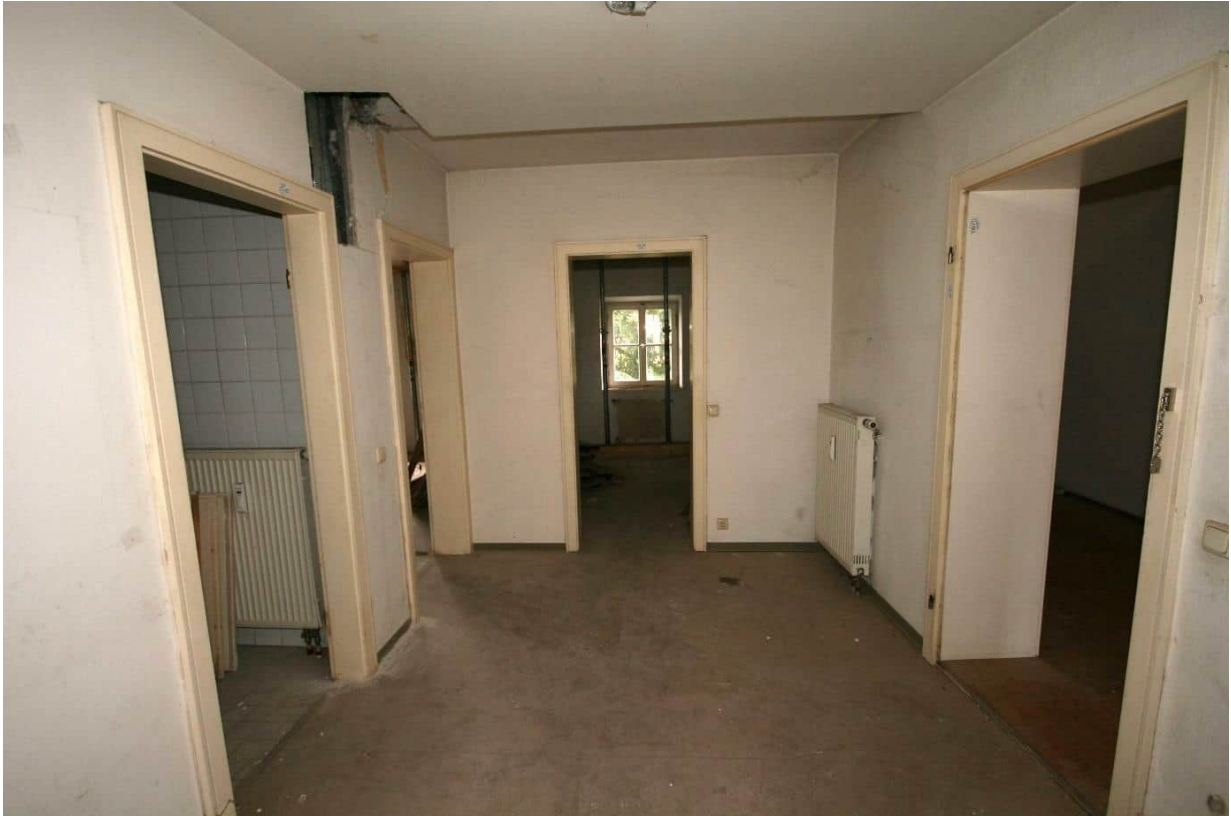
Foto Nr. 21 OG, Übersicht nördliche Diele Raum Nr. 1.10 nach Osten: Boden und Decke wie vor;
