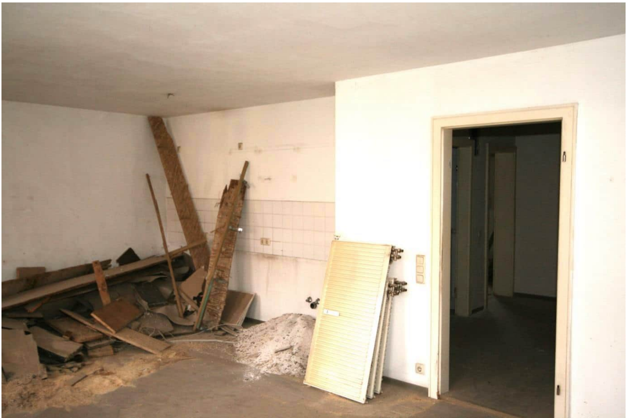
Foto Nr. 24 OG, Übersicht Raum Nr. 1.09 nach Nordosten;
