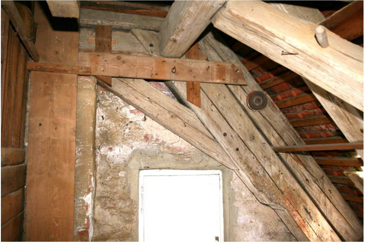
Foto Nr. 116 DG1, Raum Nr. 3.04 nach Norden, Detail zu Foto Nr.113: Binder 5= liegende Stuhlsäule, Sparren, hochrechteckiges Längsrähm, Kehlbalcken, Kopfbüge zwischen Bundbalcken und Stuhlsäule eingezapft;
