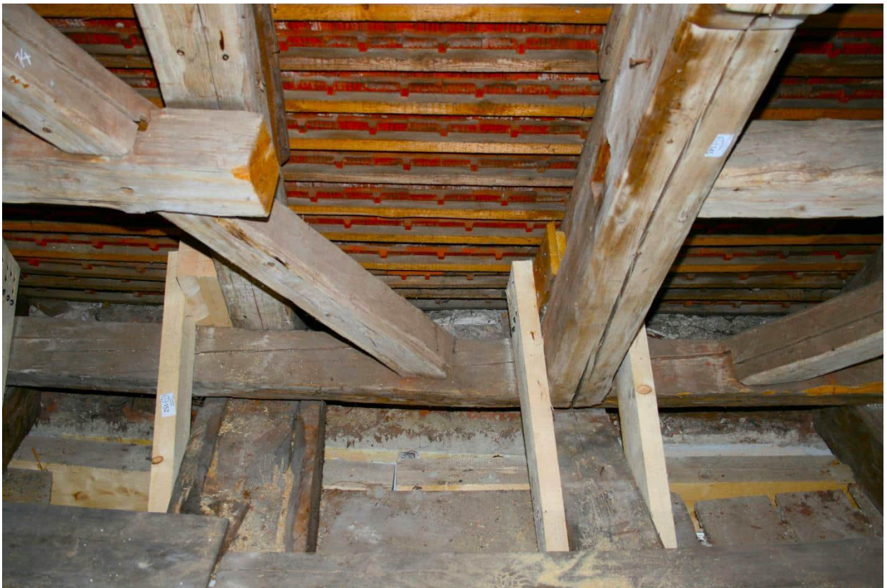
Foto Nr. 105 DG1, Raum Nr. 3.04 nach Westen: Detail Foto 104;
