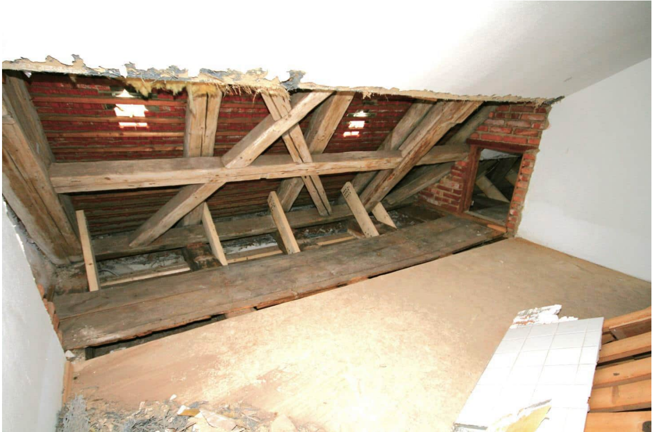
Foto Nr. 97 DG1, Raum Nr. 3.02 nach Nordwesten: Ausschnitt Liegender Kehlbalkendachstuhl wie vor;
