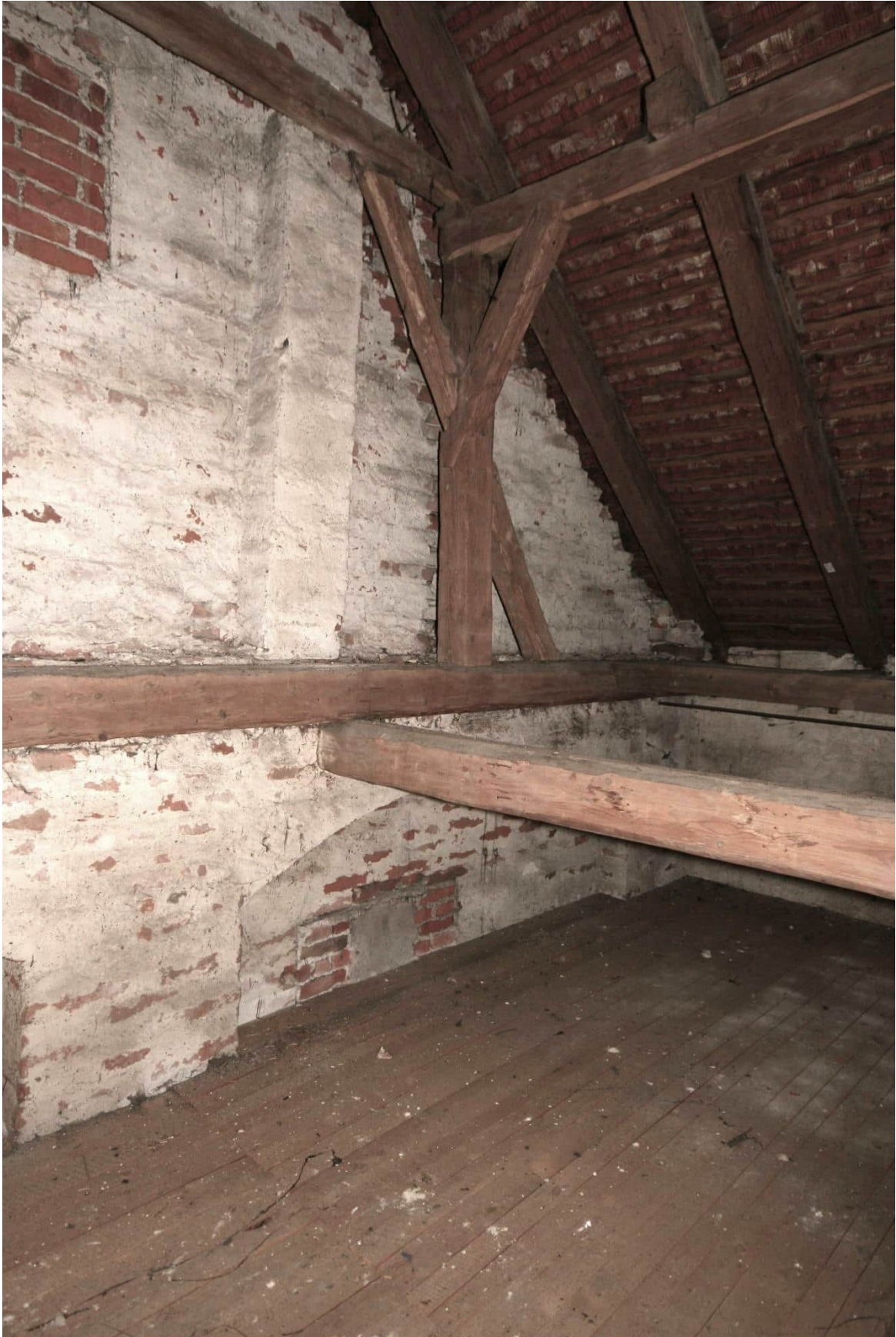
Foto Nr. 43 R.1.11 nach Nordosten: unterer Bereich der Nordwand in Sparmauerweise errichtet; Gemauerte Pfeilervorlage der oberen Wandbereichs sitzt auf Zerrbalken; Einbindung des Querbalkens über Stichbogen (!);
