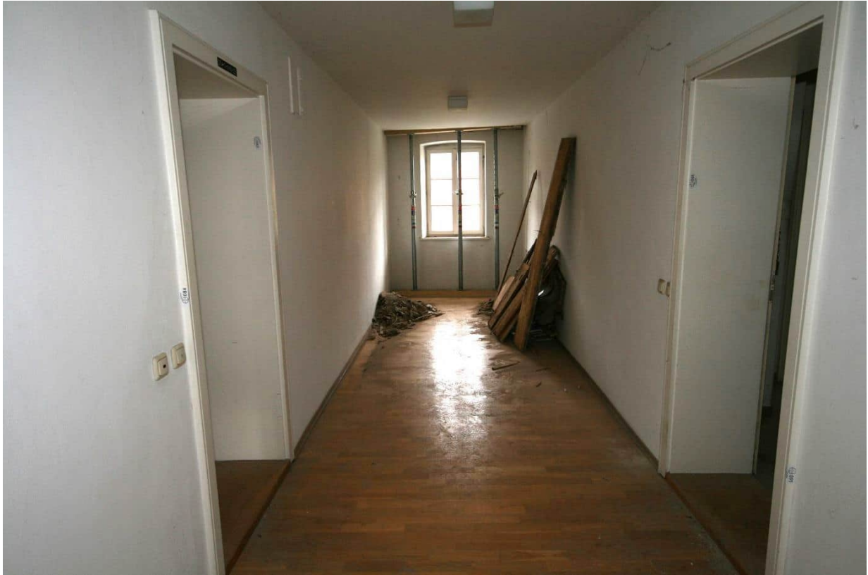
Foto Nr. 10 OG, Übersicht Raum Nr. 1.05, Querflur nach Westen; Boden: PVC-Belag auf Estrich, Decke: Gipskarton, darüber Putzdecke auf Haselruten und Bretterlage als Putzträger; Hintergrund: Statische Präventivmaßnahmen zur Gebäudesicherung;
