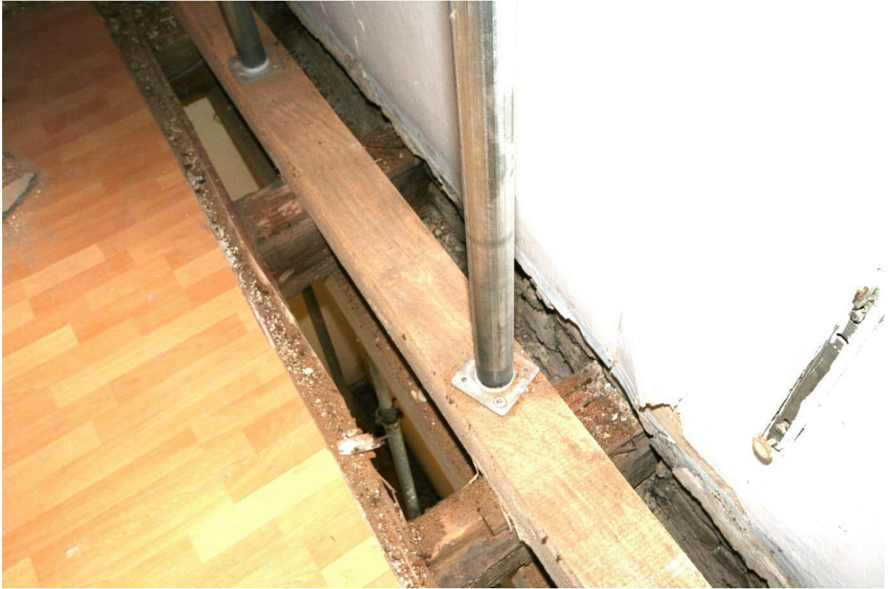
Foto Nr. 14 OG, Raum Nr. 1.04 nach Norden: Bodenausschnitt mit Blick auf die Balkenlage über EG;
