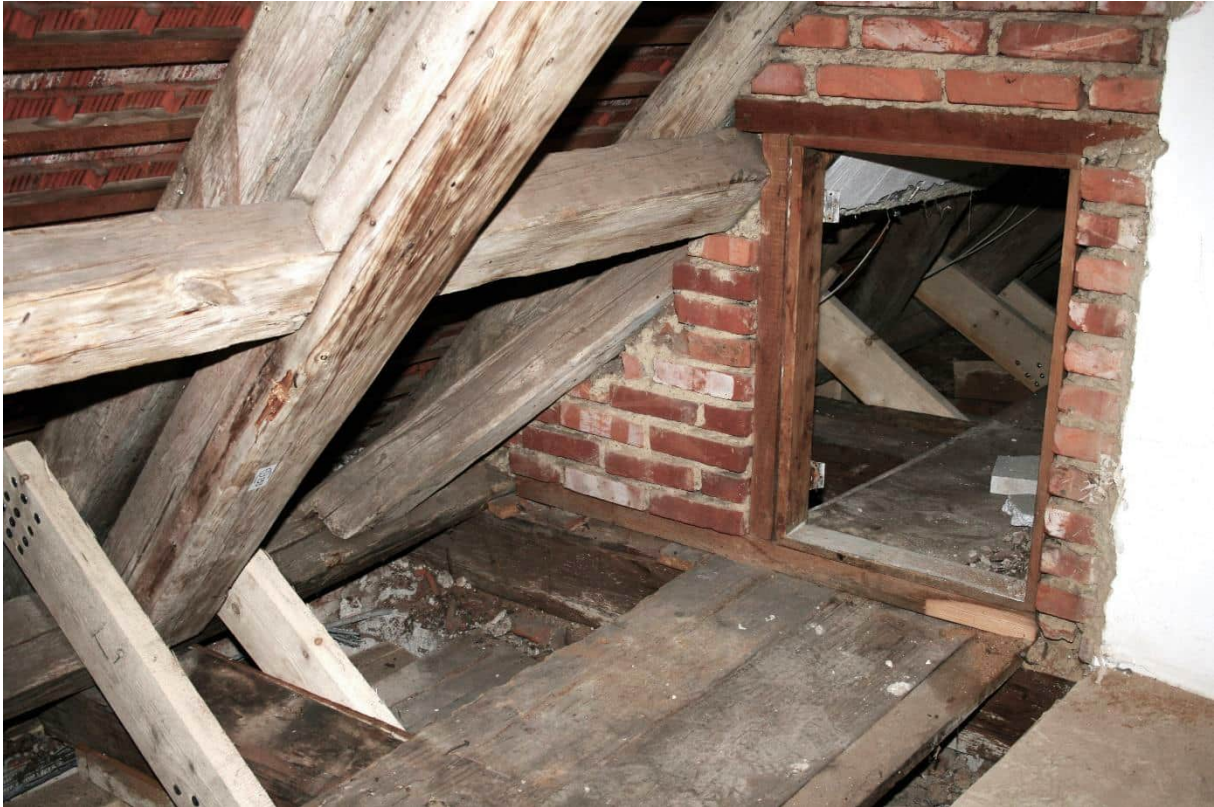
Foto Nr. 99 DG1, Raum Nr. 3.02 nach Nordwesten, Ausschnitt Bundachse 2:
