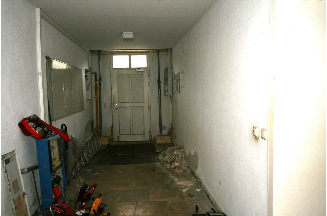
Foto Nr. 59 EG, Übersicht Raum Nr. 0.05 nach Westen: Durchgehender Querflur, Boden: Kalksteinplatten, Decke verputzt;
