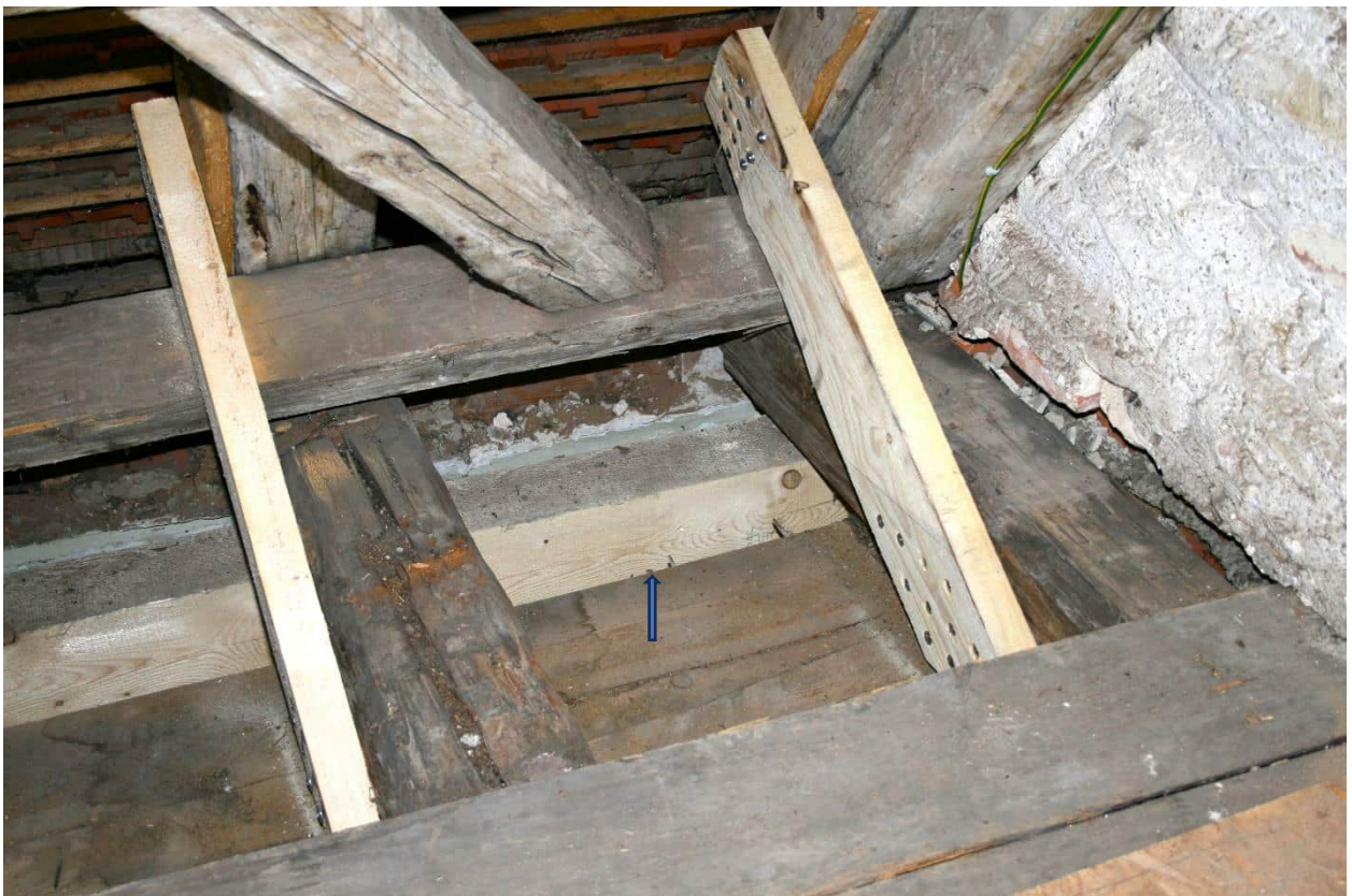
Foto Nr. 119 DG1, Raum Nr. 3.04 nach Südosten, Traufdetail: Zerrbalkenköpfe werden mit untergelegter Längsschwelle gesichert (Pfeil);
