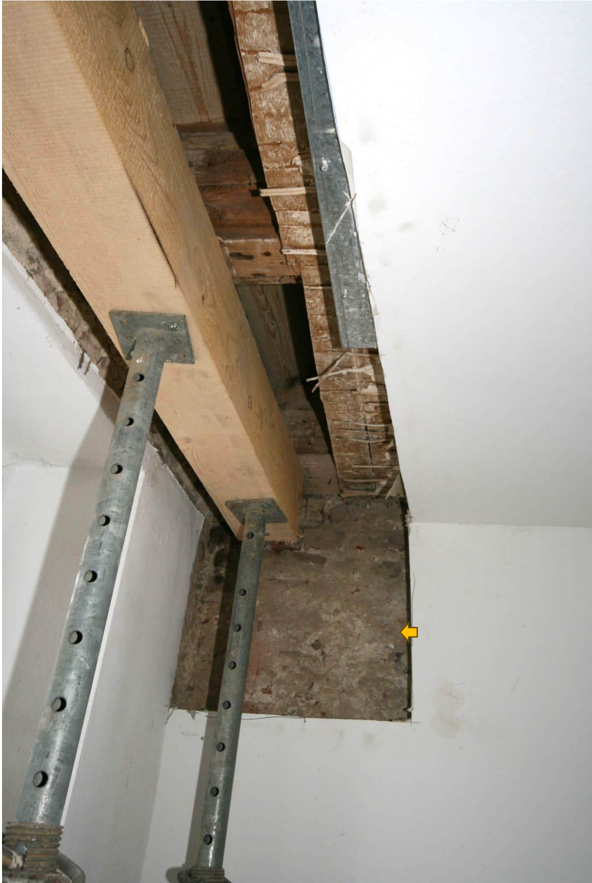
Foto Nr. 71 EG, Übersicht Raum Nr. 0.10 Norden, Deckenausschnitt: Putzdecke mit Haselruten auf Brettern als Putzträger unter Gipskartondecke auf Trägerkonstruktion mit darüber liegender Deckenbalkenlage wie vor; Pfeil: Bauzeitliche nördliche Außenwand aus Vollziegelmauerwerk unter Gipskartonwand;
