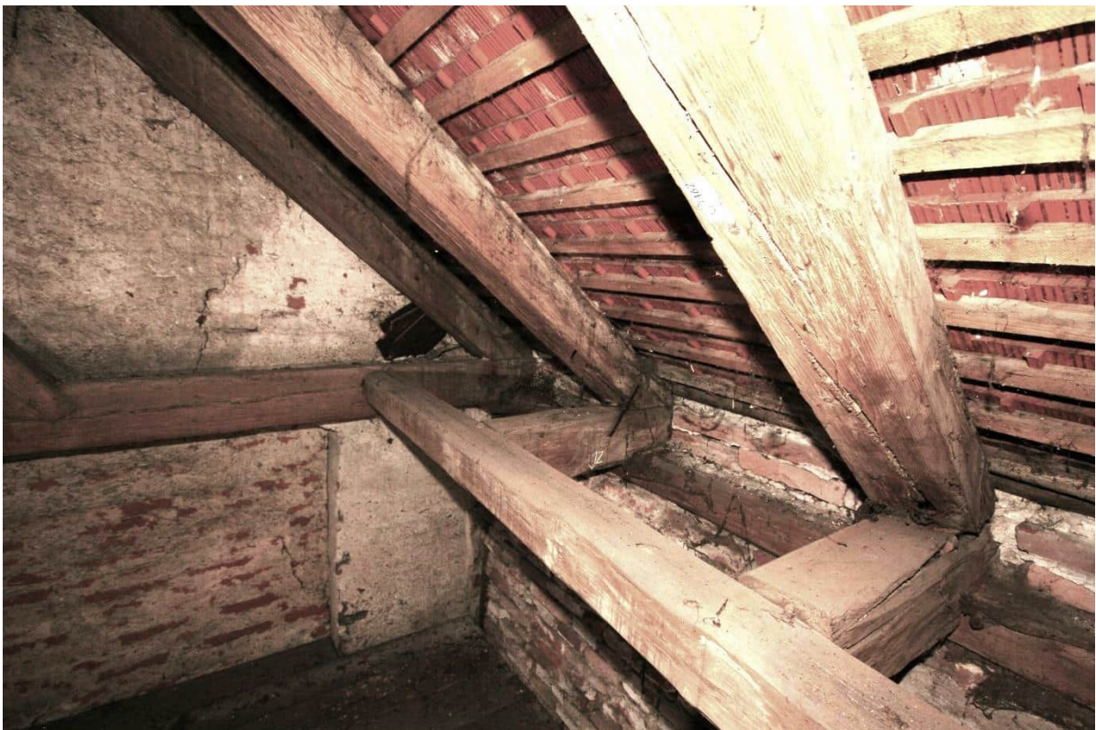
Foto Nr. 38 R.1.11 nach Südwesten, Stichbalken auf Mauerlatte mit Einbindung der Sparren und Wechselbalken:
