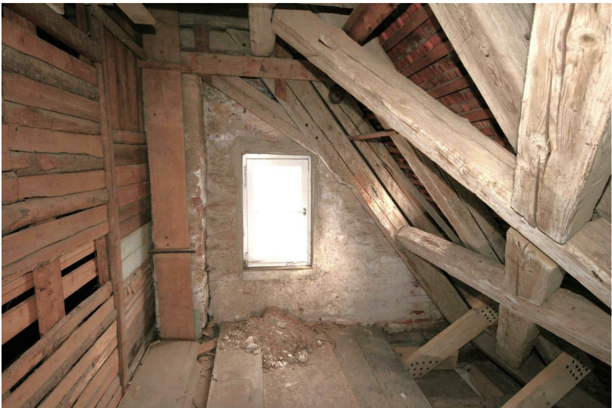
Foto Nr. 113 DG1, Raum Nr. 3.04 nach Norden: Östlicher Bereich des Nordgiebels: gemauert, mit Pfeilervorsatz und Bundachse 5 des Kehlbalckendachstuhls;
