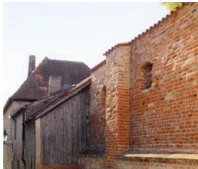
Stadtmauer nach der Sanierung mit Ziegelabdeckung der Mauerkrone
