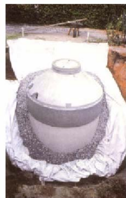
Regenwasserspeicher kombiniert mit Rigolenversickerung
