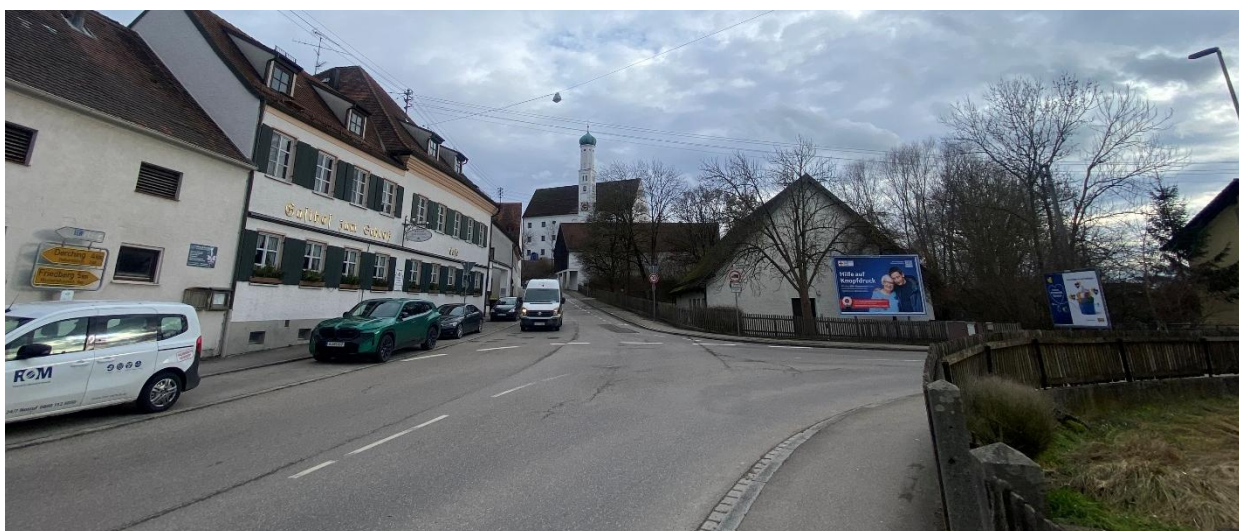
Abbildung 99: Blickachse auf die denkmalgeschützten Gebäude St. Georg Kirche und Schlossgaststätte, Pfarrer-Bezler-Straße
