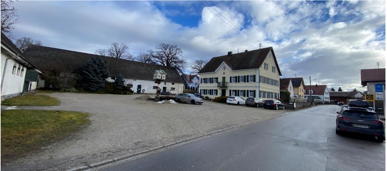
Abbildung 66: Ablesbare Altortstrukturen u. ortsbildprägende Hofstellen in der nördlichen Ringstraße,
