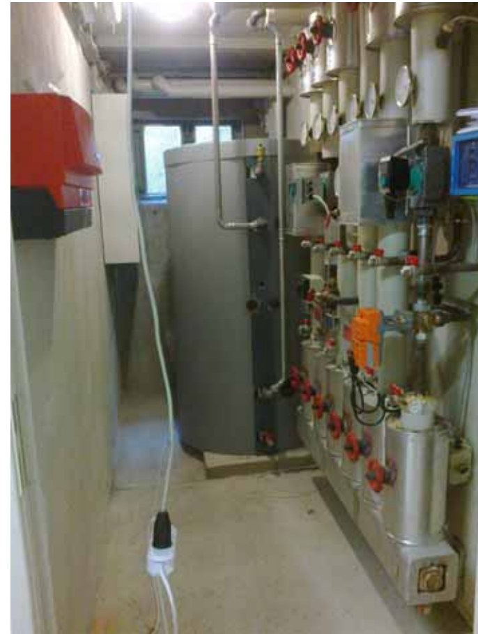
Heizungserneuerung FFW Friedberg
