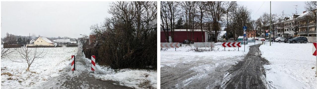
Abbildung 35: Gefahrenpunkte auf der Strecke: Poller (links) und Straßenabspernung (rechts), wobei der Durchgang eine unzureichende Breite aufweist
