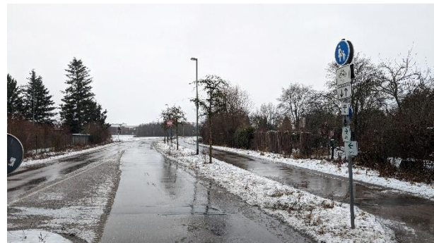
Abbildung 30: Entspricht nicht den Anforderungen an qualitativ hochwertige Radverkehrsanlagen: Die Führung über einen Gehweg innerorts (links), und über einen straßenbegleitenden Gehweg, Rad frei außerorts (rechts)
