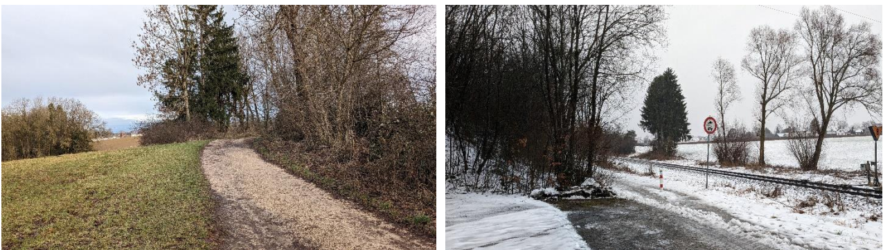
Abbildung 34: Oberflächenbeschaffenheit für Basisnetz ausreichend (links), Oberflächenbeschaffenheit für Hauptnetz unzureichend (rechts)
