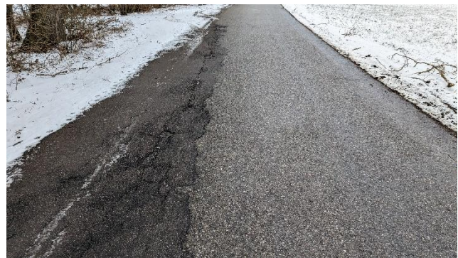
Abbildung 41: Komfortmängel im Radverkehrsnetz: kritischer Belag Hauptnetz (links), Basisnetz (rechts)
