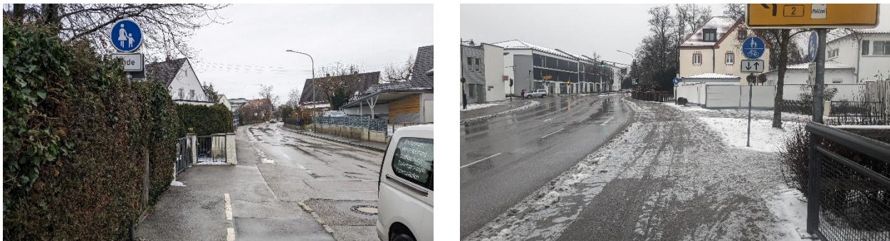
Abbildung 36: fehlende Überleitung zwischen baulichem Gehweg, Rad frei und Führung auf der Fahrbahn der Radegundisstraße (links) und fehlende Überleitung ohne Rückenschutz an der Münchner Straße (rechts)
